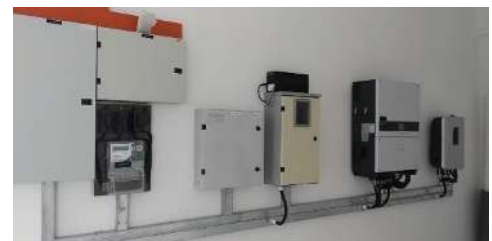
Inverter dan komponen sistem Imbangan lain
