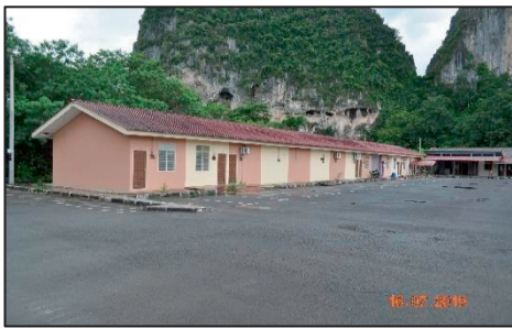
Easy Shop Bukit Keteri - Bangunan kedai tidak berpenghuni (16.07.2019)
