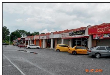
Rumah Kedai Bukit Tau - Bangunan yang Telah Disewakan (16.07.2019) (Sumber: Jabatan Audit Negara Negeri Perlis)
