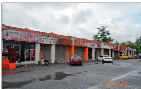
Rumah Kedai Bukit Tau - Bangunan yang Telah Disewakan (16.07.2019) (Sumber: Jabatan Audit Negara Negeri Perlis)
