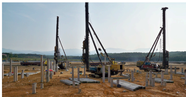
Kerja-kerja memasang cerucuk sedang dilakukan
