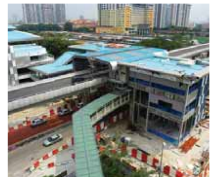
Bas Aliran Deras (BRT) - Aliran Sunway sedang dalam pembinaan dan akan dilancarkan pada Jun 2015
