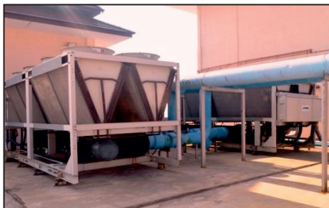
PB Sentral - Tiada Bumbung Pada Chiller (17.02.2021) (Sumber: Jabatan Audit Negara)
