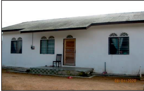
Teluk Pasu, Kuala Terengganu - Projek Bina Baharu Rumah Mangsa Kebakaran (08.01.2020) (Sumber: Jabatan Audit Negara)
