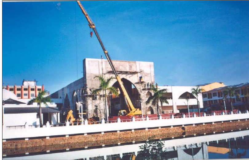
Foto 30 Bangunan Arked Yang Masih Dalam Pembinaan
