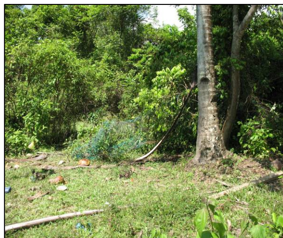
Foto 113 Sebahagian Pagar Kawasan Rumah Pam Rosak Akibat Dicerobohi
