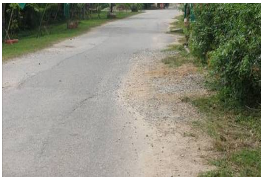
Foto 62 Keadaan Permukaan Jalan Yang Tidak Dibuat Ujian Ketebalan
