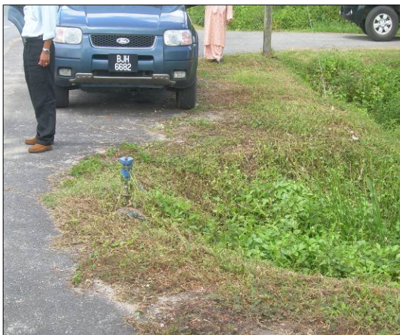
Foto 17 Paip Air Di Bahu Jalan
