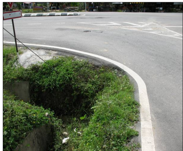
Foto 18 Longkang Di Selekoh Jalan
