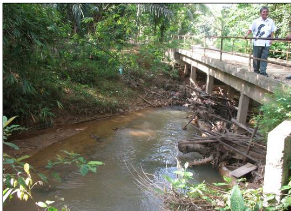
Foto 65 Kayu, Buluh Dan Sampah Sarap Tersangkut Pada Jambatan Foto 66 Kayu, Buluh Dan Sampah Sarap Tersangkut Pada Jambatan
