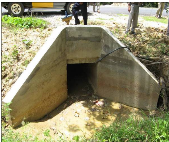
Foto 3 Pembinaan Pembetung Baru Menggunakan Wang Amanah
