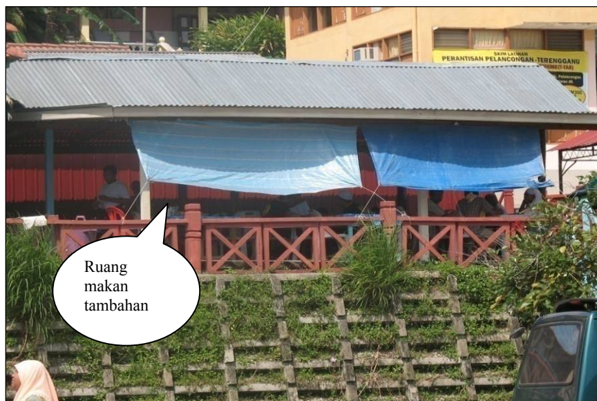
Foto 104 Ruang Tambahan Untuk Tempat Makan
