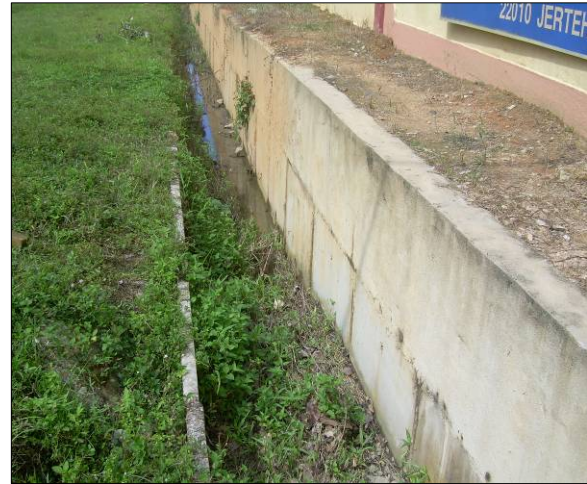
Foto 1 Pembinaan Longkang 'U Shape' Menggunakan Wang Amanah
