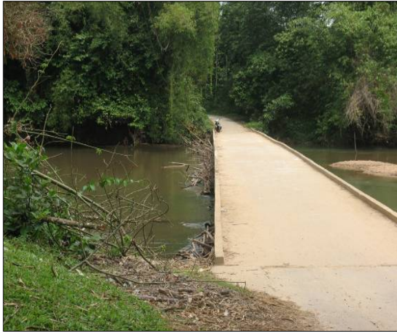
Foto 68 Jambatan Konkrit Yang Masih Dalam Keadaan Kukuh
