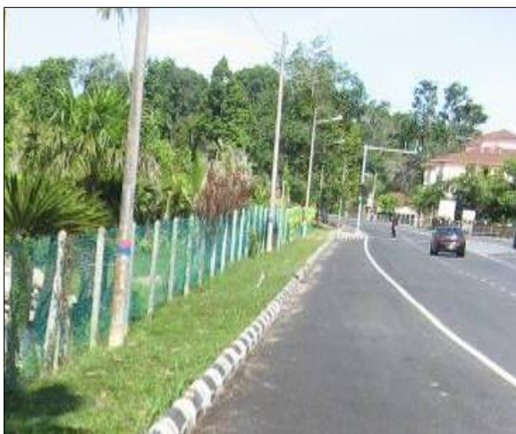
Foto 50 Pemasangan Kerb Jalan
