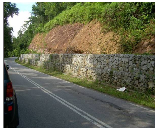
Foto 4 Pembinaan Gabion Menggunakan Wang Amanah
