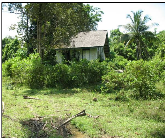
Foto 112 Keadaan Sekitar Rumah Pam Tidak Diuruskan Dengan Baik
