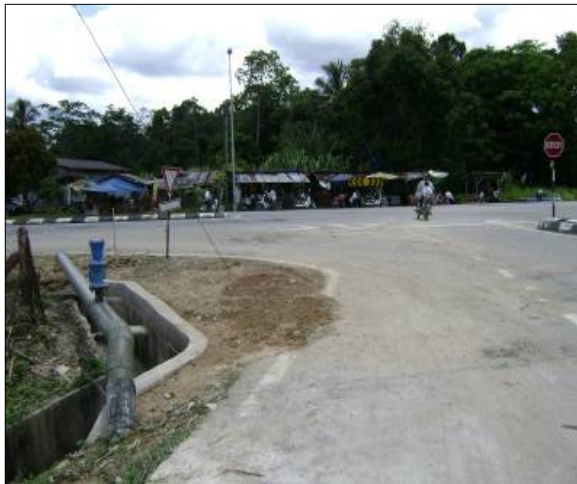
Foto 21 Longkang Di Selekoh Jalan Telah Dibaiki
