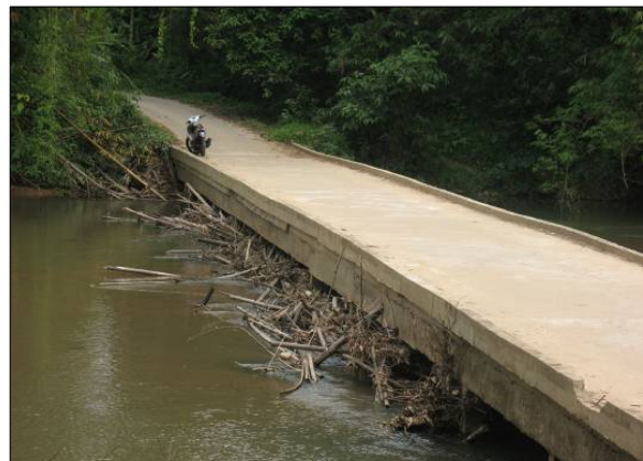
Foto 65 Kayu, Buluh Dan Sampah Sarap Tersangkut Pada Jambatan Foto 66 Kayu, Buluh Dan Sampah Sarap Tersangkut Pada Jambatan
