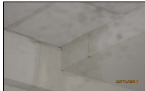
Bangunan Kedai/Pejabat Blok C, Pekan Ajil - Bumbung Bocor Menyebabkan Kesan Air di Siling (20.12.2016)
