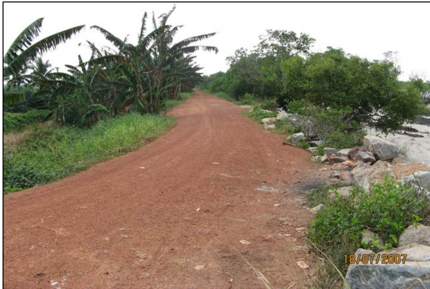
Sumber: Foto Jabatan Audit Negara Tarikh: 18 Julai 2007 Lokasi: Sg. Kajang
