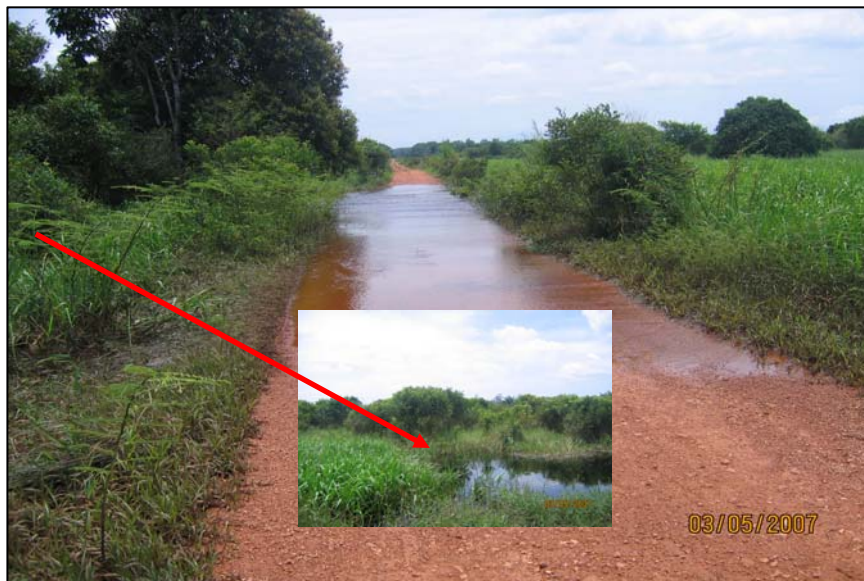
Foto 93 Kawasan Ladang Sungai Panjang Berpayu Menyebabkan Jalan Ladang Ditenggelami Air Pada Musim Hujan
