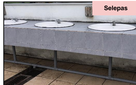
Pantai Morib - Bahagian Bawah Sinki Di Medan Selera Telah Dibersihkan dan Paip PVC Telah Ditukar (19.05.2017)
