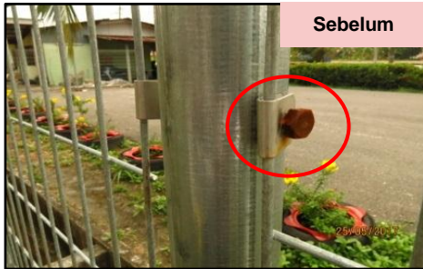
Jalan Permai 2, Taman Sijangkang Permai - Bolt and Nuts Bukan Jenis Stainless Steel (25.05.2017)
