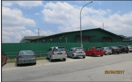
Tanah Rizab Surau, Taman Perindustrian KIP - Binaan Bangunan Tambahan di Atas Tanah Rizab Surau yang Telah Dipagar (20.04.2017)
