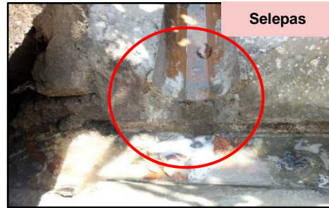
Jalan Wira 20 & 26, Taman Perwira, Telok Panglima Garang - Pemasangan Longkang Telah Dikemaskan (27.07.2017)
