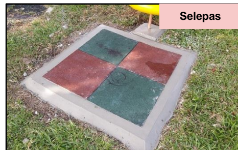
Jalan Semilang 5, Taman Seri Putra, Banting - Kerja Lepaan Simen di Sekeliling Rubber Mat Telah Dikemaskan (30.05.2017)
