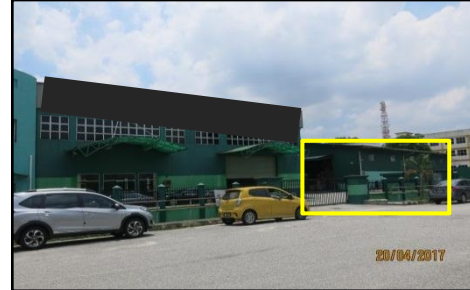
Tanah Rizab Surau, Taman Perindustrian KIP - Binaan Bangunan Tambahan di Atas Tanah Rizab Surau yang Tidak Mendapat Kelulusan Pelan Bangunan MPS (20.04.2017)
