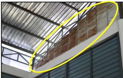
Gerai Fasa Satu, Taman Greenwood - Aluminium Louvres pada Dinding Tepi Bahagian Dalam Gerai Telah Berkarat (09.05.2017)
