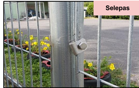
Jalan Permai 2, Taman Sijangkang Permai - Bolt and Nuts Diganti Dengan Jenis Stainless Steel (30.05.2017)
