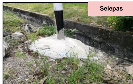
Pasar Awam Sungai Jarom dan Medan Selera Sungai Jarom, Kuala Langat - Asas Binaan Tiang Papan Tanda Telah Dikukuhkan (21.07.2017)
