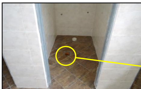
Gerai Fasa Dua, Taman Greenwood - Kedudukan Lubang Perangkap Lantai di Tandas Perempuan Tidak Mengikut Lukisan Senibina (09.05.2017)
