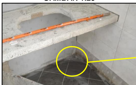
Gerai Fasa Dua, Taman Greenwood - Tiada Lubang Perangkap Lantai Dibina Seperti Dalam Lukisan Senibina (09.05.2017)
