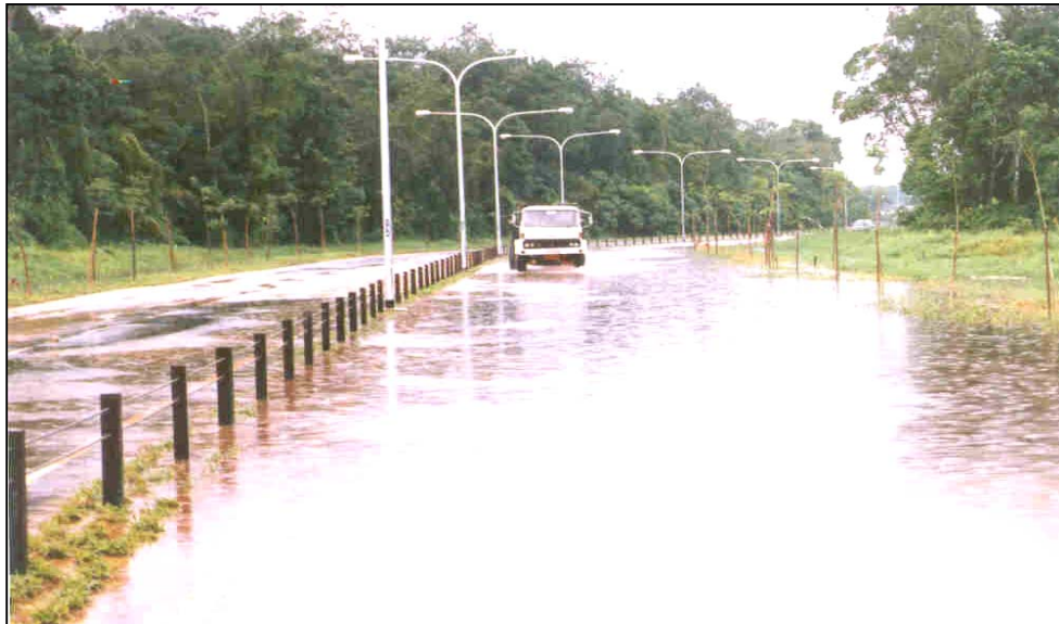
Foto 4 Projek Saliran Di Jalan Pedada, Sibul Tidak Dapat Mengatasi Masalah Banjir Sepenuhnya
