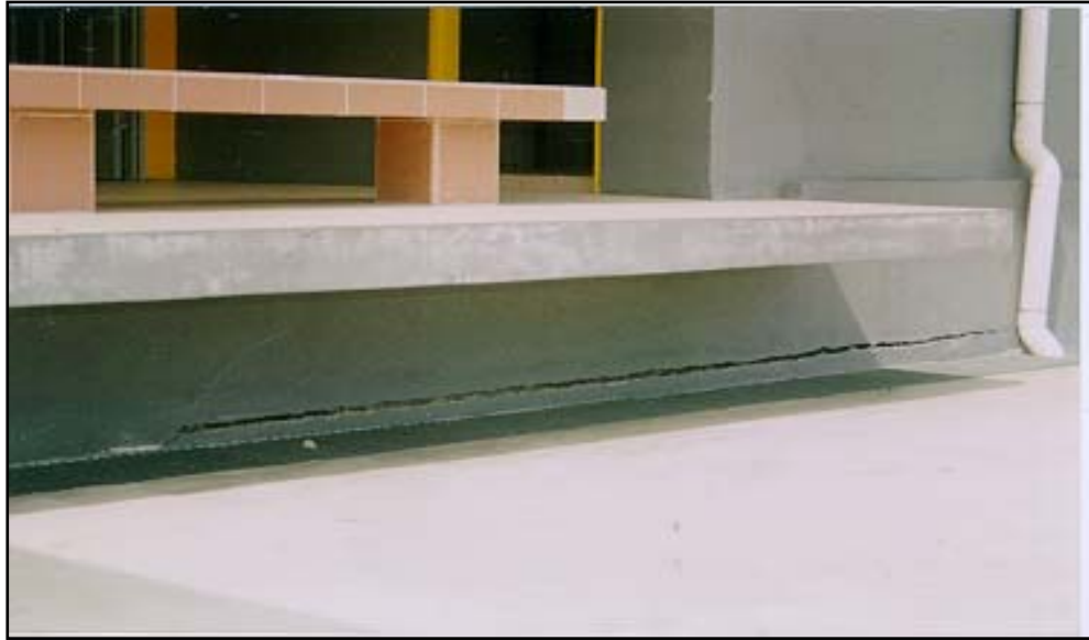
Sumber: Fail Foto Jabatan Audit Negara Tarikh : 21 Mei 2003
