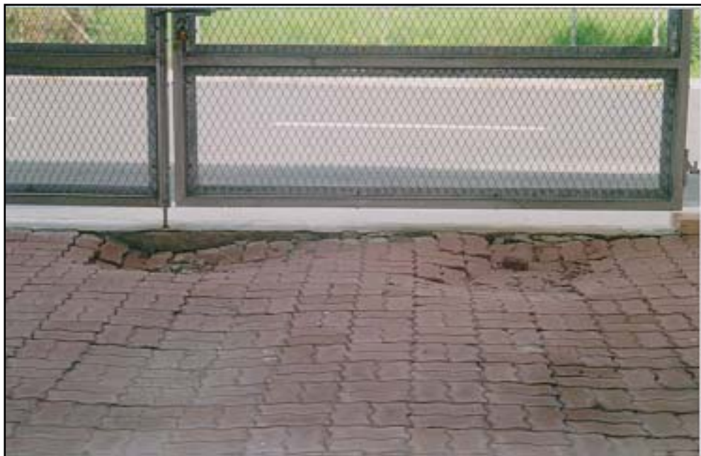
Sumber: Fail Foto Jabatan Audit Negara Tarikh : 21 Mei 2003
