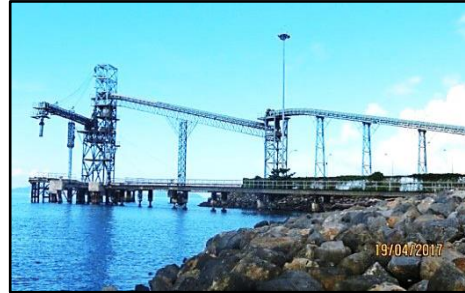
Pelabuhan Kunak Conveyer System Untuk Palm Kernel Extract Handling Facilities (04.04.2017)
