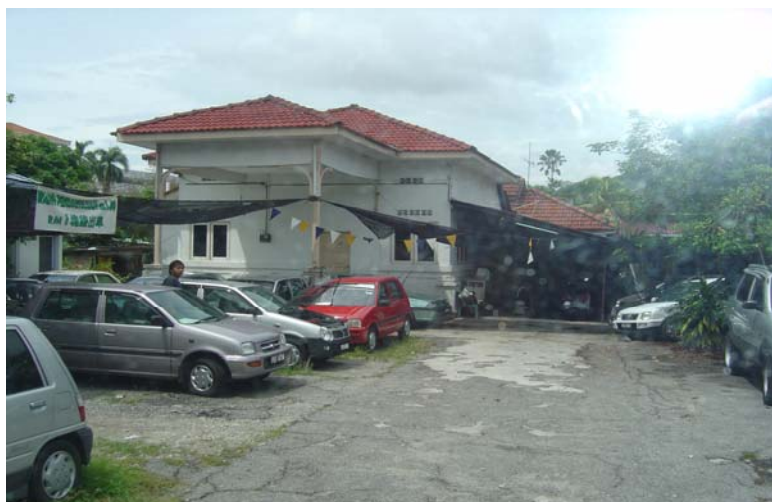
Foto 19 Sewaan Kecil Tanpa Kebenaran Majlis
