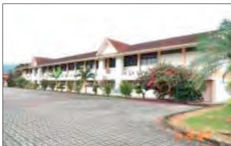
Lot 2378, Mukim Beseri - Sebahagian Daripada Bangunan MTAQ yang Dijual Kepada MAIPs (29.11.2017)
