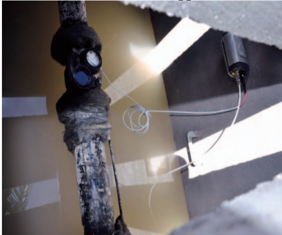
Gambar 12.1 Pengesanan Ke atas Kebocoran Kaedah Data Logger
