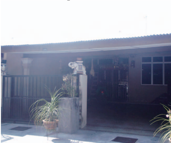
Gambar 3.19 Rumah Diubahsuai Dan Dipasang Dengan Sliding Door Anti Karat
