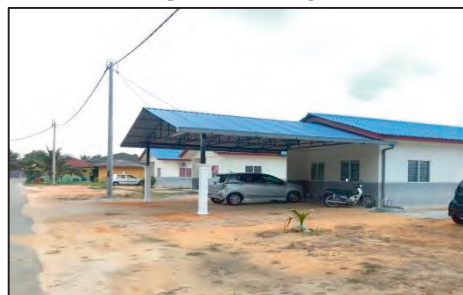
Projek RP Taman Wazir, Lekir - Ubahsuai beranda/ porch (17.07.2019) Sumber: Jabatan Audit Negara
