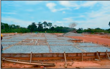
Projek RP Ulu Bernam Timur - Kerja-kerja Penyediaan Tapak Rumah (19.06.2019) Sumber: Jabatan Audit Negara
