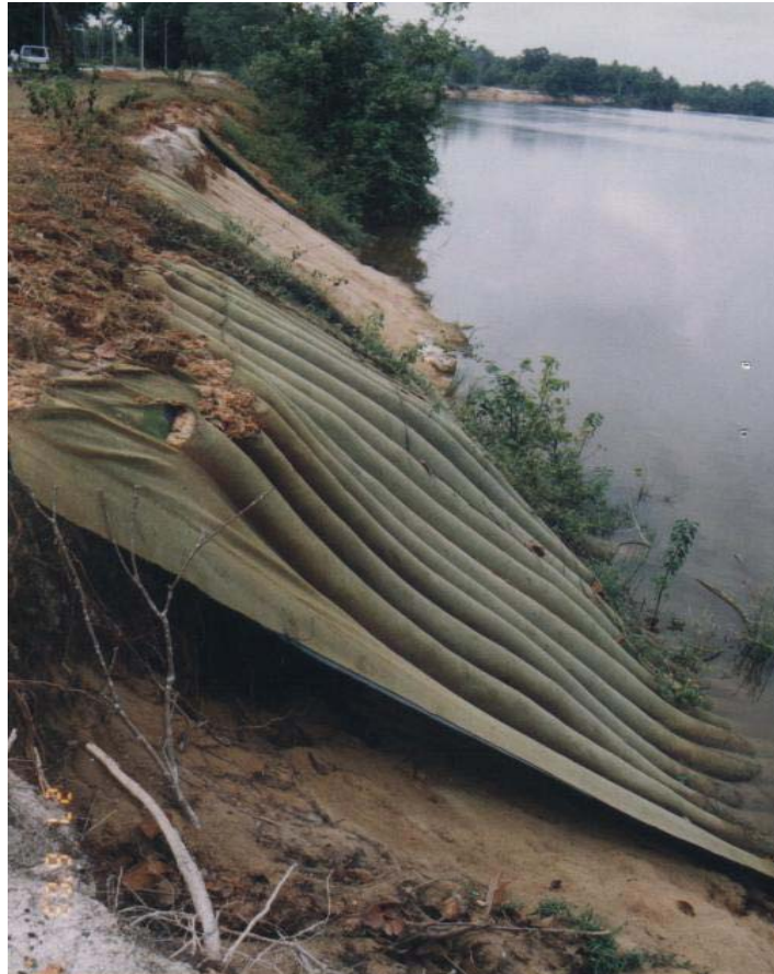
Foto 8 Keadaan Tebing Yang Runtuh Semula Menggunakan Kaedah Profix Sand Filled Mattress Di Sungai Rompin, Kg. Rantau Panjang, Rompin
