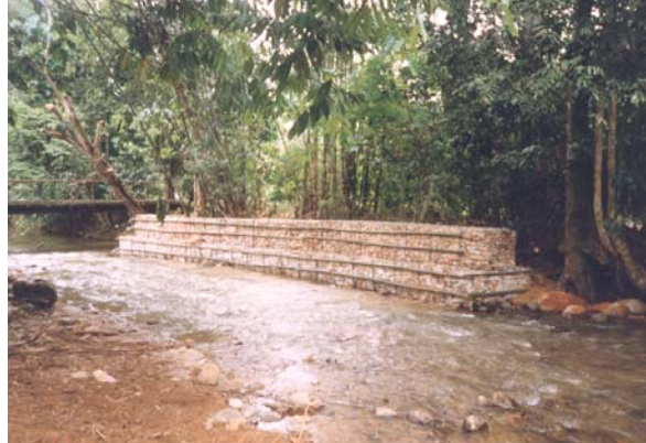
Selepas Pemasangan Gabion
