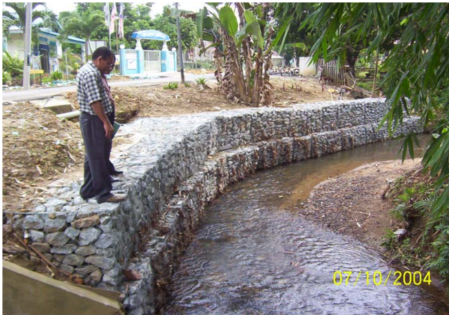
Foto 4 Penggunaan Gabion Di Sungai Semei, Bentong
