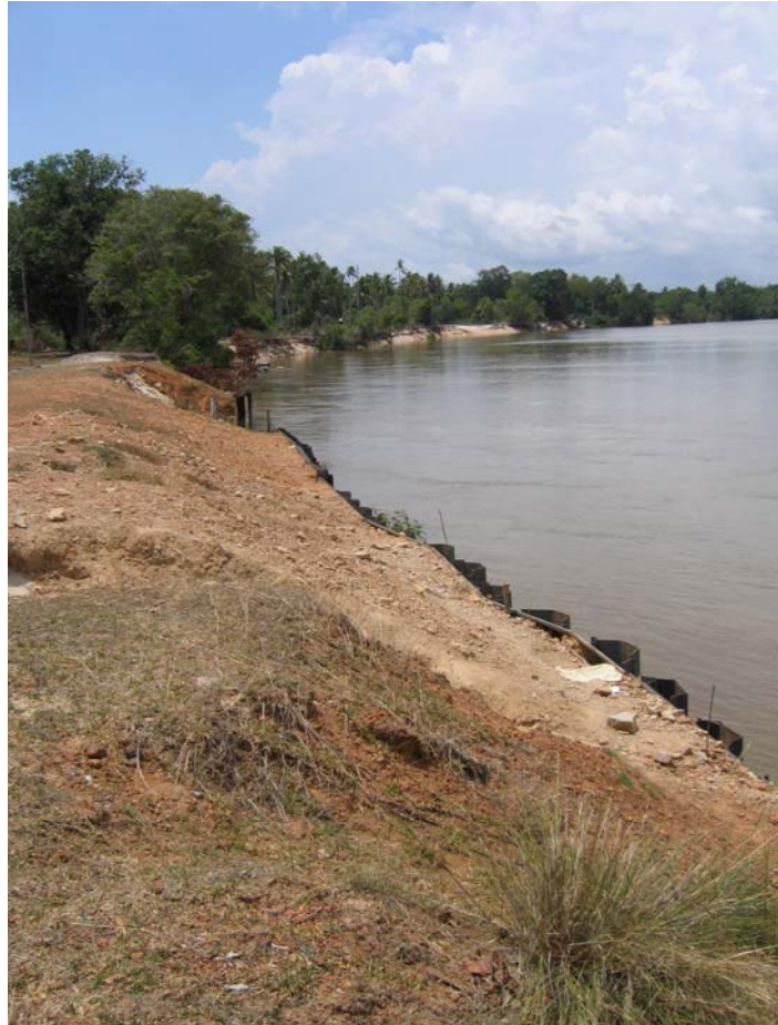
Foto 9 Keadaan Tebing Setelah Diperbaiki Menggunakan Cerucuk Keluli Di Sungai Rompin, Kg. Rantau Panjang, Rompin
