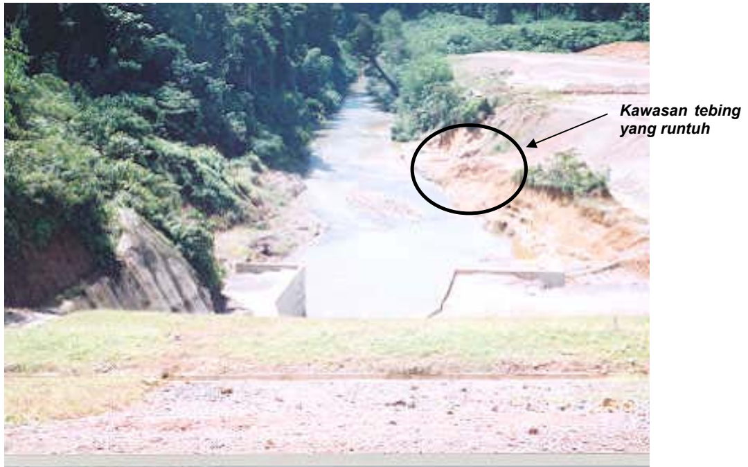
Foto 2 Tebing Sungai Yang Runtuh Kerana Tiada Perlindungan
