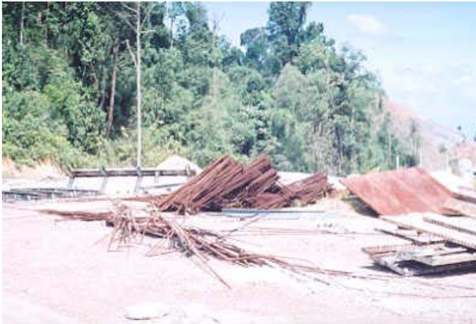
Keadaan Besi Yang Dibiarkan Terdedah.
