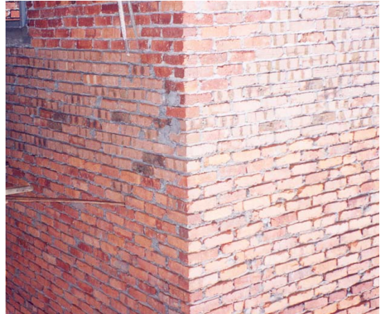
Foto 15 Pertemuan Antara 2 Dinding Yang Tidak Ada Stiffener
