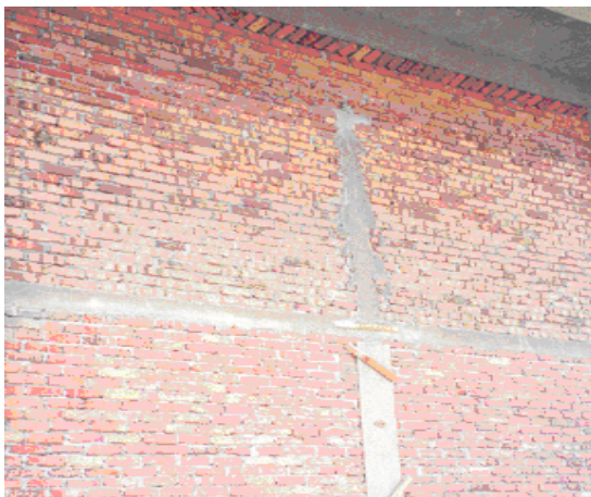
Foto 16 Stiffener Yang Dipasang Tidak Lengkap
