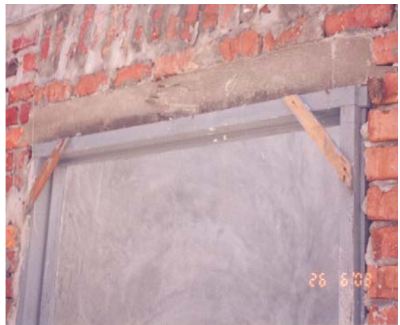
Foto 17 Lintol Yang Dipasang Tidak Mengikut Piawaian
