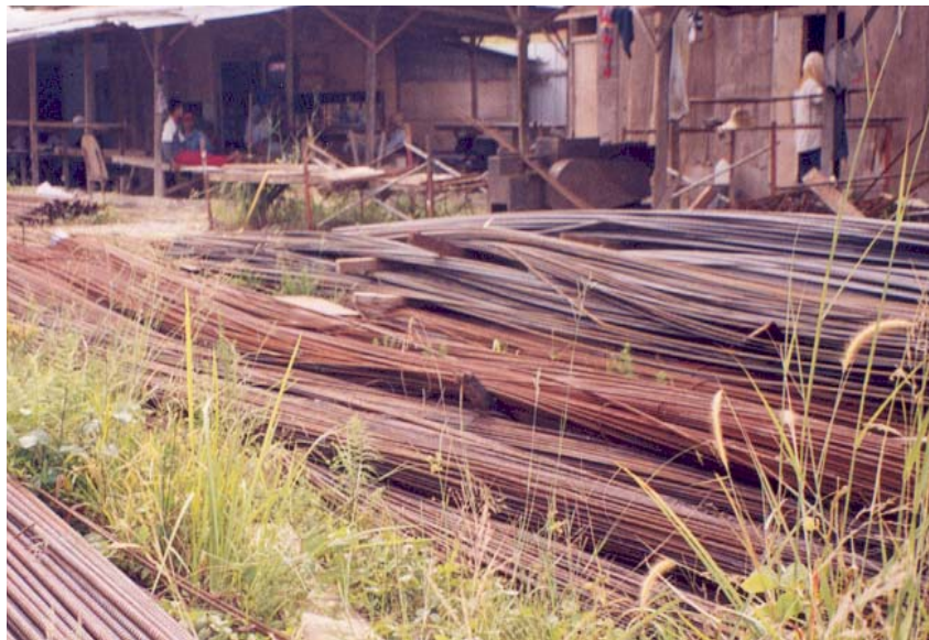
Foto 12 Longgokan Besi Yang Terdedah Kepada Panas Dan Hujan
