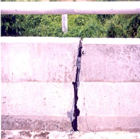
Foto 3 Rentasan Keretakan Di Jambatan Jalan Batang Benar, Ladang Cairo, Nilai
