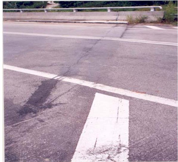
Foto 4 Jambatan Jalan Batang Benar, Ladang Cairo, Nilai
