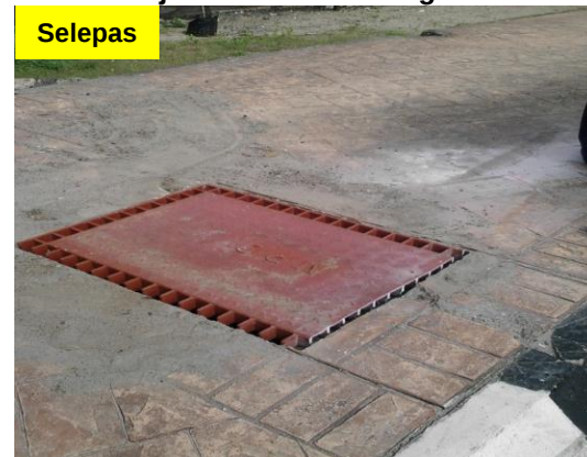
Gambar 1.27 Manhole Longkang Di Laluan Pejalan Kaki Telah Diganti
