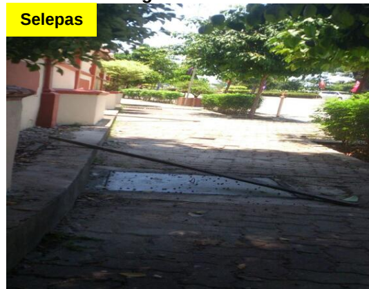
Gambar 1.25 Pembinaan Penutup Manhole Yang Telah Dibaiki
