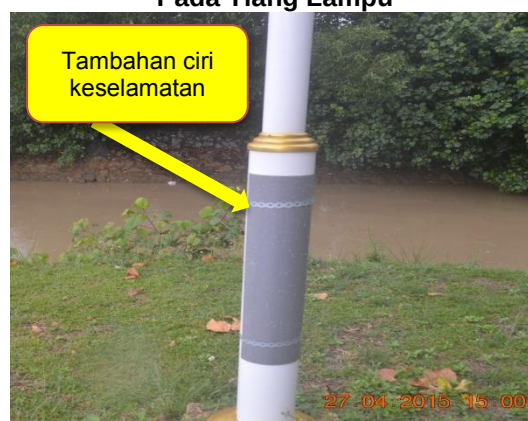
Gambar 1.12 Tambahan Ciri Keselamatan Pada Tiang Lampu
