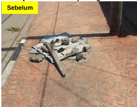
Gambar 1.26 Manhole Longkang Di Laluan Pejalan Kaki Ditutup Dengan Zink
