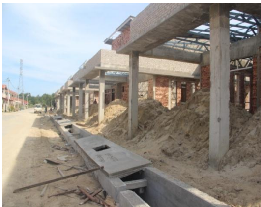
Gambar 3.3 Rumah Yang Masih Dalam Pembinaan
