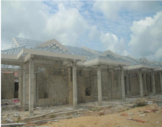
Gambar 3.1 Rumah Yang Masih Dalam Pembinaan
