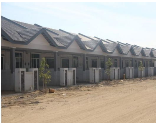
Gambar 3.2 Rumah Yang Masih Dalam Pembinaan
