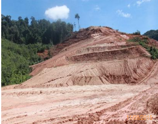
Gambar 1.19 Perlindungan Cerun Tidak Dibuat
