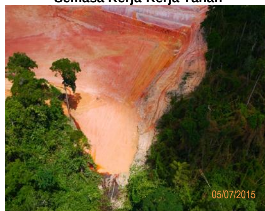
Gambar 1.18 Penolakan Tanah Ke Alur Sungai Semasa Kerja-Kerja Tanah
