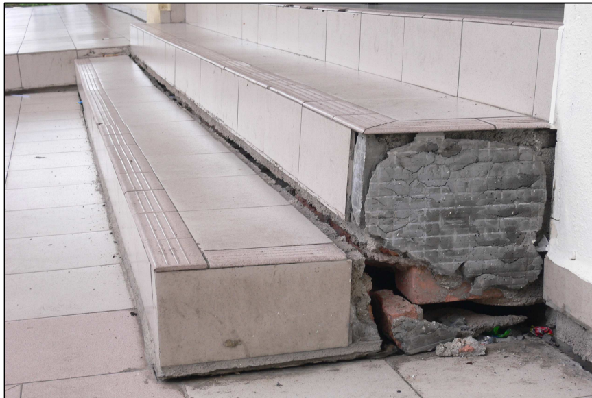
Foto 13 Enapan Tanah Di Terminal Teksi
