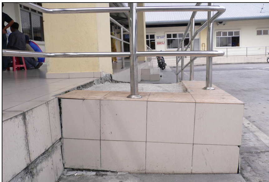
Foto 12 Enapan Tanah Di Terminal Bas Ekspres
