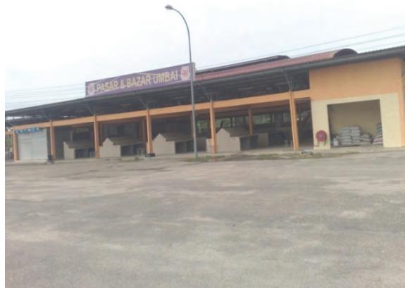
Sumber : Jabatan Audit Negara Lokasi : Pasar Baru Umbai, Jasin (MPJ) Tarikh : 24 Oktober 2009
