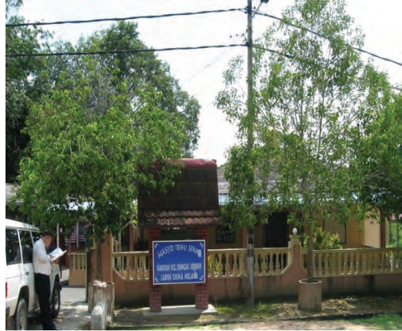
Foto 6.4 Masjid Sungai Jernih
