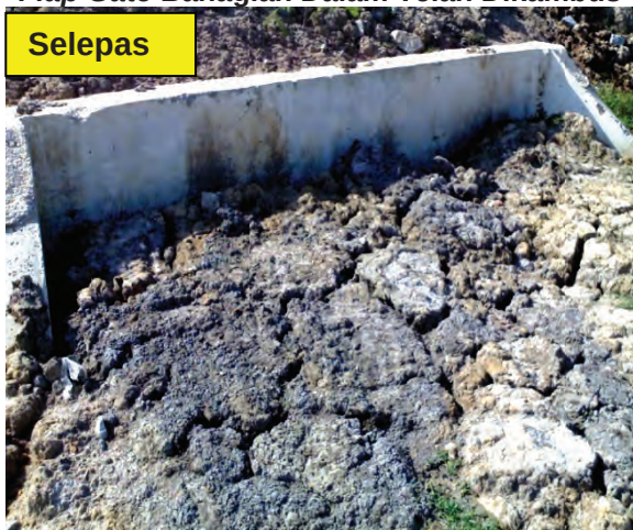
Foto 4.18 Flap Gate Bahagian Dalam Telah Dikambus
