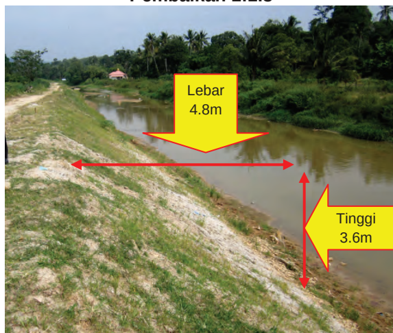
Foto 3.3 Nisbah Kecerunan Tebing Selepas Kerja Pembaikan 1:1.3
