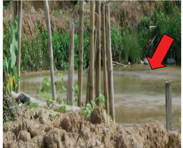
Sumber : Jabatan Audit Negara Lokasi : Kolam Takungan Ke-2, Kg.Gadek Tarikh : 5 November 2009
