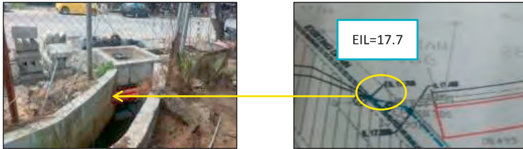
Earth Drain - Existing Invert Level (EIL) (11.01.2018)
