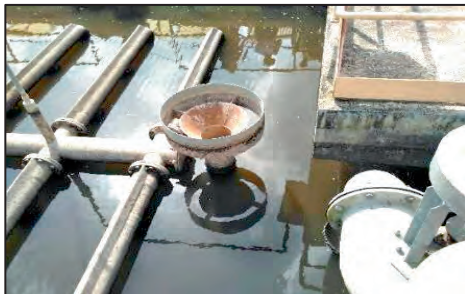
LRK Perumahan JPN Padang Tembak - Warna Kumbahan yang Normal di Tangki Pengudaraan (28.02.2017)
