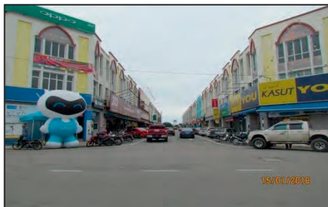
Blok C, D, E Dan F -Sebahagian Daripada 108 Lot Perniagaan/ Komersial Fasa 1 yang Telah Siap (15.01.2018)
