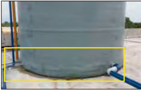
Elevated Tank di Blok Asrama SMSTG - Plinth Tidak Dipasang Pada Tangki (11.01.2018)
