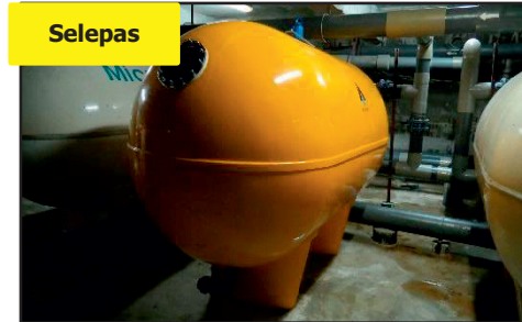
Kompleks Akuatik, Gunung Keriang - Penapis Air Telah Diganti Baharu (24.02.2021) (Sumber: Jabatan Audit Negara)
