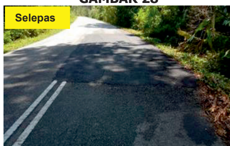
K020 - Jalan Sintok / Padang Sanai - Pembaikan Telah Siap Dijalankan (10.9.2020) (Sumber: JKR Daerah Kubang Pasu)
