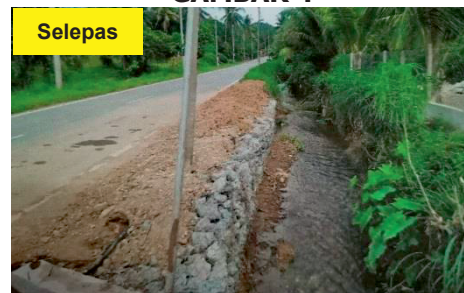
K107 - Kubang Betong (Kubang Pasu) - Baik Pulih Tebing Sungai yang Terhakis (8.10.2019) (Sumber: JKR Daerah Kubang Pasu)
