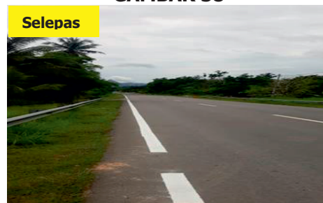
Jalan Batu 42 / Gulau (TEKIH) - Jalan Telah Dicat Garisan Tepi (10.9.2020) (Sumber: JKR Daerah Baling)
