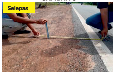
Jalan Batu 20/Kerpan, Kubang Pasu - Bahu Jalan Siap Telah Disenggara (10.09.2020) (Sumber: Jabatan Audit Negara)
