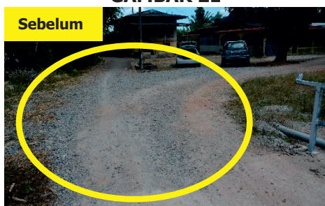
Jalan Kg. Batu 20 1/2 , Padang Pusing, Pendang - Jalan Kampung Belum Diturap (Aduan) (30.03.2020) (Sumber: Jabatan Audit Negara)
