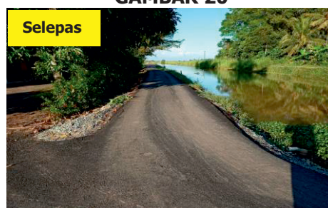
Kg. Alor Parit, Mukim Bukit Raya, Pendang - Jalan Telah Disenggara (02.11.2020) (Sumber: PDT Pendang)
