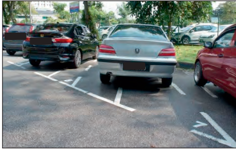
Jalan Syed Mohd Mufti - Garisan Petak Kereta Bertindih (10.06.2019) (Sumber: Jabatan Audit Negara)
