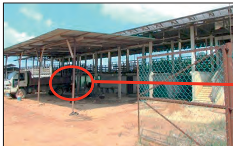
Ladang Alaf, Kulai - Kandang Kambing yang Dijadikan Bengkel oleh Kontraktor Ladang (28.07.2019) (Sumber: Jabatan Audit Negara)
