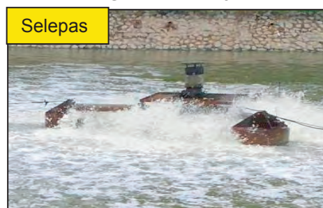
LRK Taman Cempaka (JBBT37) - Kerosakan Surface Aerator Telah Dibaiki dan Berfungsi (Ogos 2017) Sumber: MBBJ
