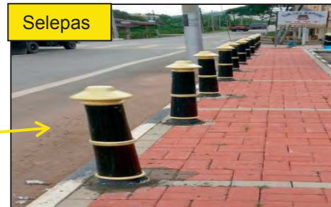
Selepas Jalan Susur, Bukit Kepong - Bollard Dipasang Telah Dibaiki (28.02.2018)
