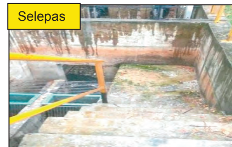
LRK Taman Cempaka (JBBT37) - Kerosakan Telah Dibaiki dan Incoming Chamber Telah Berfungsi (Ogos 2017) Sumber: MJB
