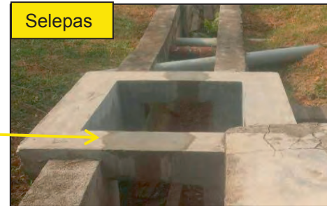
Selepas Pentas Utama Pintu B, Stadium Sultan Ibrahim - Lepaan Permukaan Longkang Telah Dibaiki (28.02.2018)
