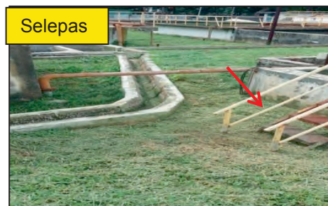
LRK Taman Tampoi Indah Kipmart - Air Kumbahan yang Bertakung Telah Bersihkan (Ogos 2017) Sumber: MBJB
