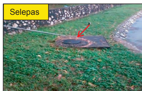
LRK Taman Cempaka - Penutup Lurang Telah Diganti (19.09.2017) Sumber: MBBJ
