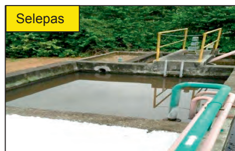
LRK Taman Kempas Indah (JBU114) - Algae Dalam Tangki Efluen Telah Dibersihkan (Ogos 2017) Sumber: MJB
