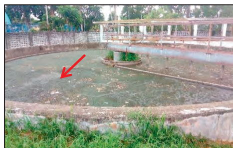
LRK Taman Tampoi Indah Kipmart (JBBT33) - Sludge Hardening di Tangki Mendapan (09.03. 2017)
