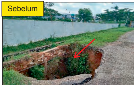
LRK Taman Cempaka (JBBT37) - Mendapan Tanah Dalam Kawasan LRK (09.03.2017)
