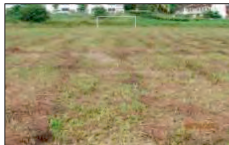
Padang Awam Lenga - Permukaan Padang Tidak Rata (30.10.2017)
