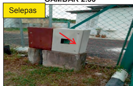
LRK Taman Kempas Indah (JBU114) - Kotak Fius dan Meter TNB Telah Ditutup (Julai 2017) Sumber: MBBJ
