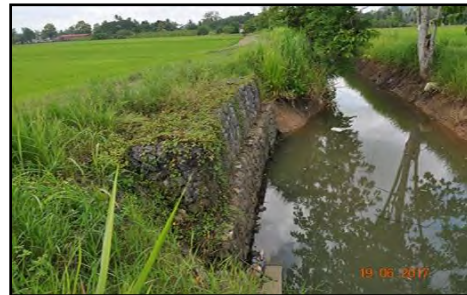
Sungai Jernih, Kampung Kubang Tiga - Struktur Kawalan Hakisan Tebing Semasa Pemeriksaan Audit (19.6.2017)
