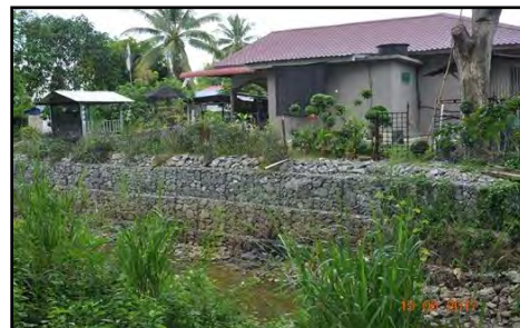
Lorong Haji Hassan, Kampung Salang - Struktur Kawalan Hakisan Tebing Semasa Pemeriksaan Audit (15.6.2017)
