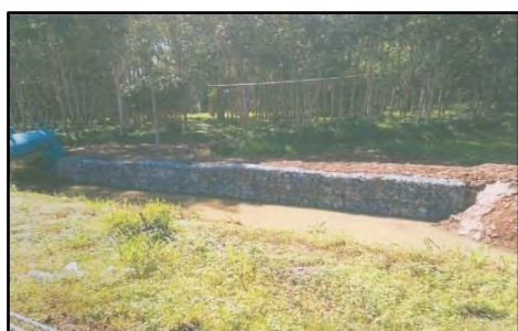
Sungai Chempa, Kampung Badang Chempa - Struktur Kawalan Hakisan Tebing Semasa Kerja Baharu Disiapkan (Jun 2014) (Sumber: JPS Negeri Perlis)
