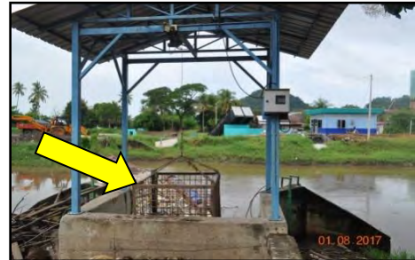
Sungai Perlis - Komponen Mengangkat Sampah Berfungsi Dengan Baik (1.8.2017)
