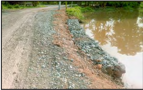
Sungai Arau, Kampung Rambai - Struktur Kawalan Hakisan Tebing Semasa Kerja Baharu Disiapkan (Jun 2016) (Sumber: JPS Negeri Perlis)
