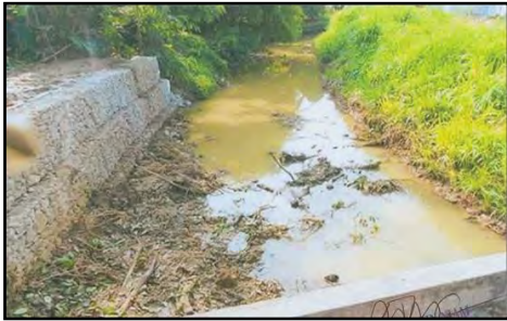
Sungai Panggas, Kampung Panggas Besar - Struktur Kawalan Hakisan Tebing Semasa Kerja Baharu Disiapkan (Julai 2015) (Sumber: JPS Negeri Perlis)
