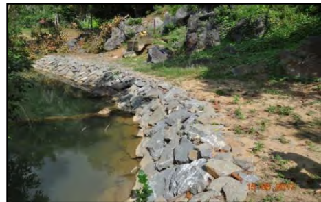
Sungai Pelarit, Titi Tinggi - Struktur Kawalan Hakisan Tebing Semasa Pemeriksaan Audit (15.6.2017)
