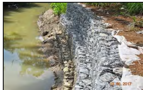
Sungai Abi, Kampung Belukar - Struktur Kawalan Hakisan Tebing Semasa Pemeriksaan Audit (19.6.2017)
