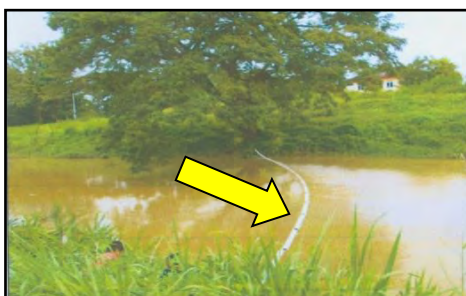
Sungai Korok/Lencongan Utara - Floating Rubbish Trap Semasa Baharu Dipasang (Disember 2014) (Sumber: JPS Negeri Perlis)
