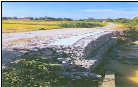
Sungai Jernih, Kampung Kubang Tiga - Struktur Kawalan Hakisan Tebing Semasa Kerja Baharu Disiapkan (Jun 2016) (Sumber: JPS Negeri Perlis)
