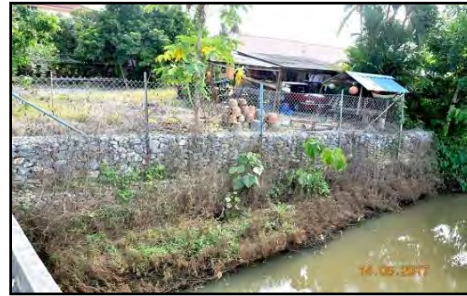
Sungai Panggas, Kampung Panggas Besar - Struktur Kawalan Hakisan Tebing Semasa Pemeriksaan Audit (14.6.2017)
