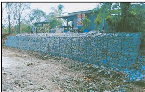
Lorong Haji Hassan, Kampung Salang - Struktur Kawalan Hakisan Tebing Semasa Kerja Baharu Disiapkan (Mei 2016) (Sumber: JPS Negeri Perlis)
