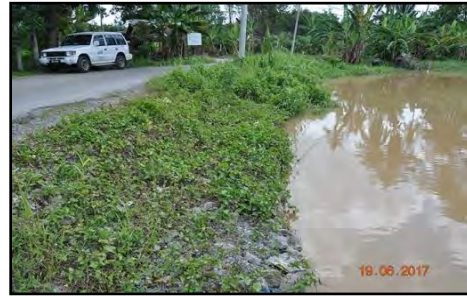
Sungai Arau, Kampung Rambai - Struktur Kawalan Hakisan Tebing Semasa Pemeriksaan Audit (19.6.2017)
