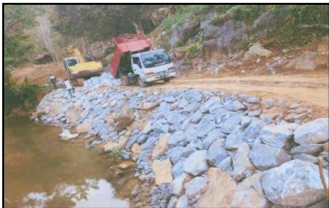
Sungai Pelarit, Titi Tinggi - Struktur Kawalan Hakisan Tebing Semasa Kerja Baharu Disiapkan (Jun 2016) (Sumber: JPS Negeri Perlis)
