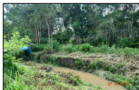
Sungai Chempa, Kampung Badang Chempa - Struktur Kawalan Hakisan Tebing Semasa Pemeriksaan Audit (7.8.2017)
