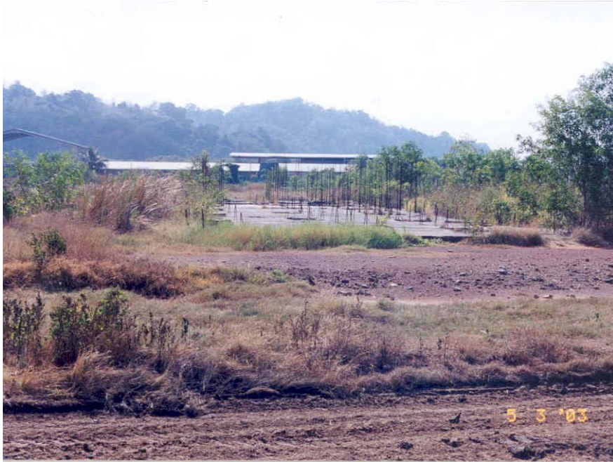
Sumber: Fail Foto Jabatan Audit Negara Lokasi : Projek Perumahan Kampung Seberang Jaya Tarikh : 5 Mac 2003
