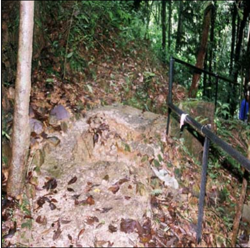
Foto 15 - Keadaan Laluan Pejalan Kaki Yang Rosak Laluan
