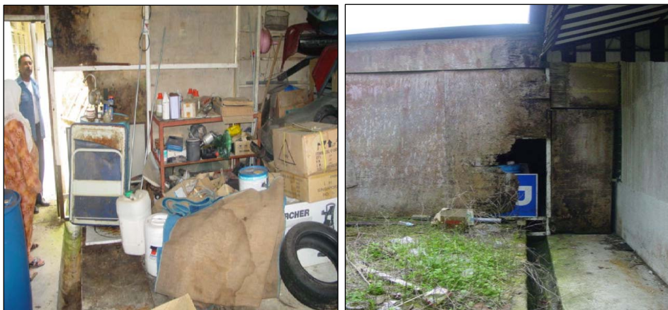
Foto 2 (Stor B) Keadaan Stor Yang Berlubang Dan Rosak Telah Diguna Untuk Menyimpan Peralatan Kenderaan Dan Barang-Barang Lama
