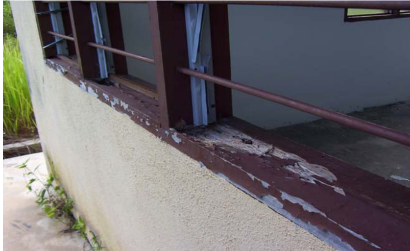
Foto 3 Keadaan Bingkai Tingkap Yang Telah Reput Projek Kuala Medang, Lipis
