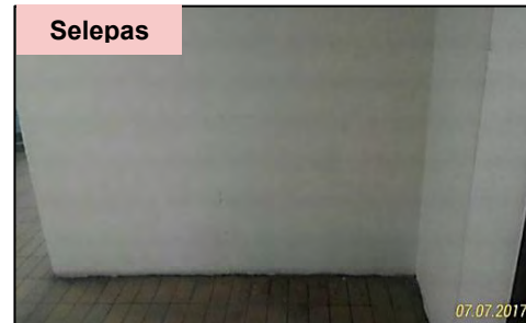
Tingkat 1, Bangunan YNS - Peralatan Mencuci Telah Dialihkan (07.07.2017)
