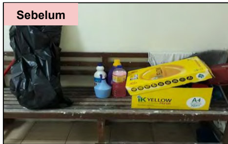
Tingkat 1, Bangunan YNS - Peralatan Mencuci Disimpan di Tepi Koridor (19.06.2017)
