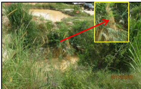
Lot 1573 Grn 74691, Lot 1574 Grn 74695, Lot 1575 Grn 74696 dan Lot 1576 Grn 74697 Mukim Pantai, Seremban - Kolam Enapan Tidak Diselenggara Dengan Baik (07.12.2016)
