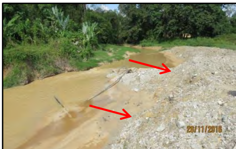
Lot 662 Grn 232447 Mukim Pantai, Seremban - Kerosakan Tebing Sungai (28.11.2016)
