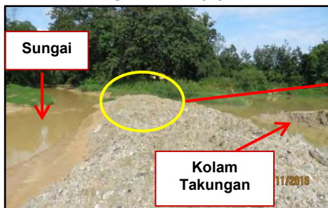
Lot 662 Grn 232447 Mukim Pantai, Seremban - Tebing Kolam yang Runtuh Menyebabkan Enapan Mengalir ke Sungai (28.11.2016)
