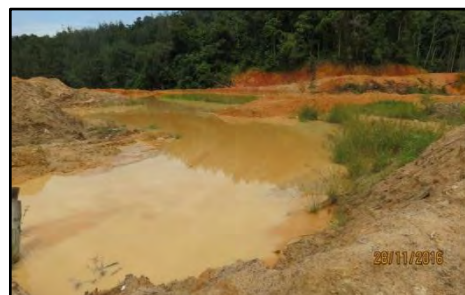
Lot 2275-2276, 1549-1592 Mukim Pantai Mukim Pantai, Seremban - Kolam Enapan Tidak Diselenggara Dengan Baik (28.11.2016)
