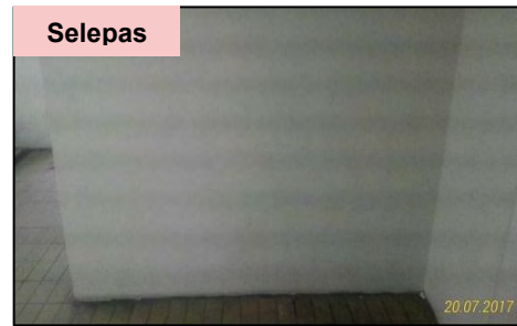
Tingkat 5, Bangunan YNS - Peralatan Mencuci Telah Dialihkan (20.07.2017)
