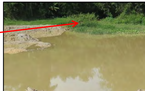
Lot 662 Grn 232447 Mukim Pantai, Seremban - Tebing Kolam yang Runtuh Menyebabkan Enapan Mengalir ke Sungai (28.11.2016)
