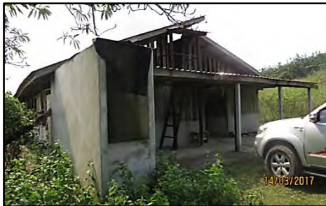
Ladang Ternakan Rusa LTSB, Kuala Pilah - Keadaan Rumah Gelap yang Telah Usang (14.03.2017)
