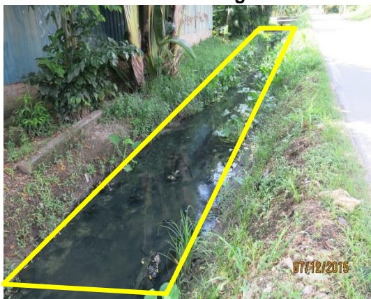
Gambar 3.1 Parit Tanah Yang Masih Belum Dinaik Taraf Kepada Longkang Konkrit
