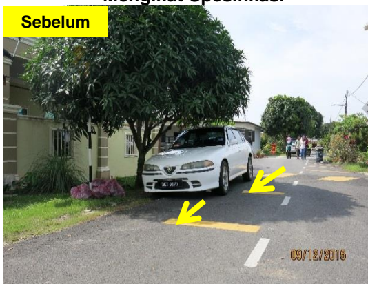
Gambar 1.14 Traverse Bar Yang Dicat Tidak Mengikut Spesifikasi
