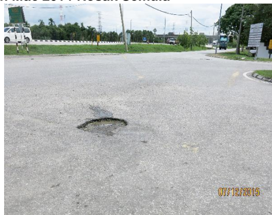
Gambar 1.32 Jalan Yang Diturap Pada Bulan Mac 2014 Rosak Semula
