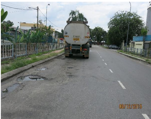
Gambar 1.30 Jalan Yang Diturap Pada Bulan Disember 2014 Rosak Semula
