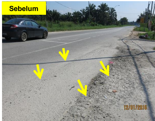
Gambar 1.5 Bahu Dan Jalan Rosak
