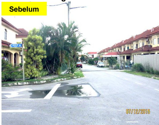
Gambar 1.20 Turapan Tidak Rata Menyebabkan Air Bertakung Di Permukaan Jalan
