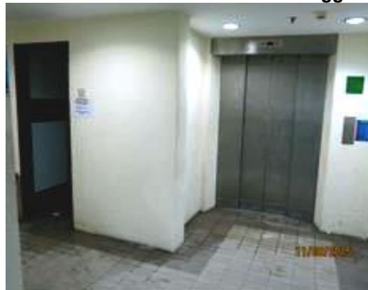
Gambar 2.5 Air Yang Bertakung Mengalir Keluar Ke Laluan Lif Tidak Selamat Untuk Pengguna
