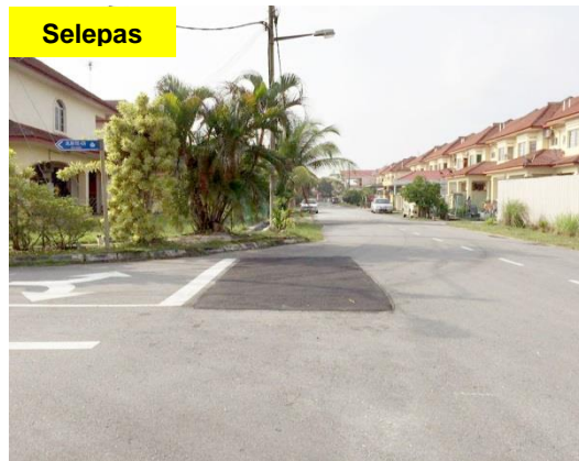
Gambar 1.21 Kerja Turapan Pada Permukaan Jalan Tidak Rata Telah Dilaksanakan
