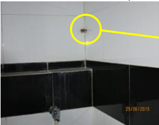
Gambar 2.10 Kedudukan Paip Kawalan Yang Rapat Dengan Dinding
