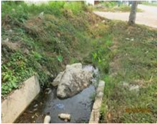
Gambar 2.13 Keadaan Longkang Yang Tidak Siap
