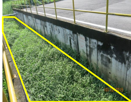
Gambar 3.4 Longkang Ditumbuhi Rumput
