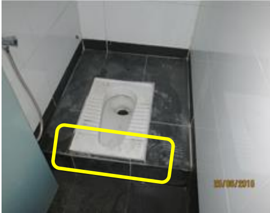
Gambar 2.6 Perbezaan Jarak Pemasangan Mangkuk Tandas
