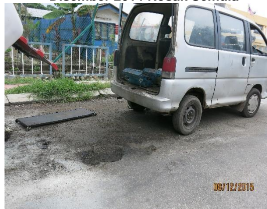
Gambar 1.29 Jalan Yang Diturap Pada Bulan Disember 2014 Rosak Semula
