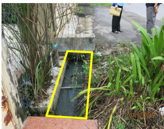
Gambar 1.13 Air Bertakung Disebabkan Longkang Hadapan Rumah Penduduk Tidak Disenggara
