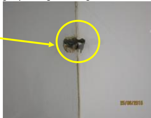
Gambar 2.10 Kedudukan Paip Kawalan Yang Rapat Dengan Dinding
