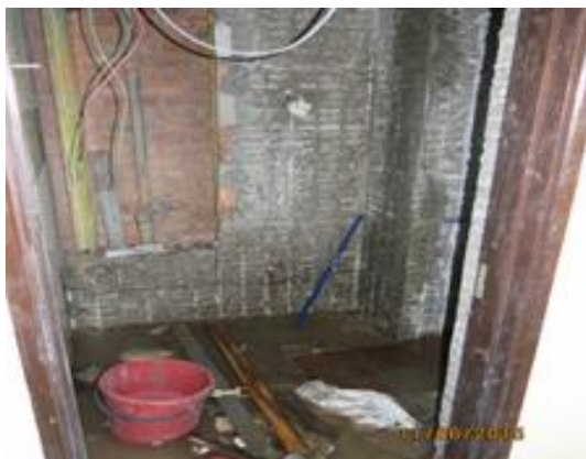
Gambar 2.4 Air Bertakung Di Dalam Tandas VIP
