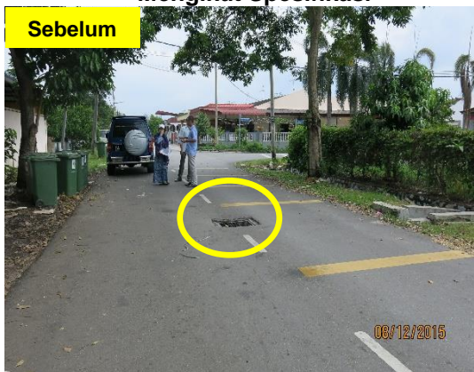
Gambar 1.18 Manhole Mendap Kerana Turapan Tidak Mengikut Spesifikasi
