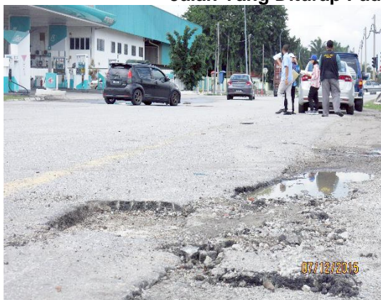
Gambar 1.32 Jalan Yang Diturap Pada Bulan Mac 2014 Rosak Semula
