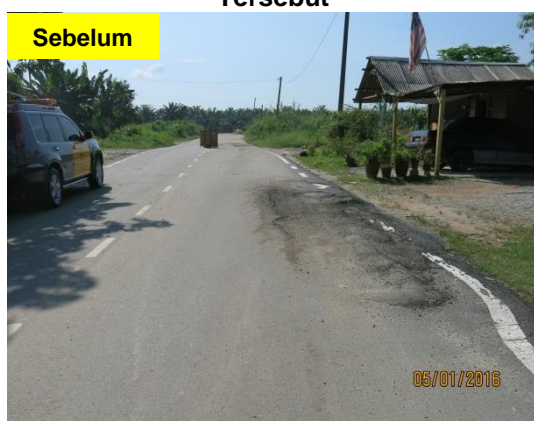
Gambar 1.24 Jalan Yang Diturap Pada Bulan November 2015 Rosak Semula Kerana Kenderaan Yang Melebihi Had Muatan Menggunakan Jalan Tersebut
