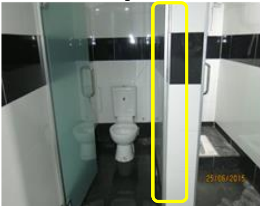
Gambar 2.8 Getah Sesudut Jubin Tidak Dipasang Di Dinding Tandas
