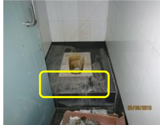
Gambar 2.6 Perbezaan Jarak Pemasangan Mangkuk Tandas
