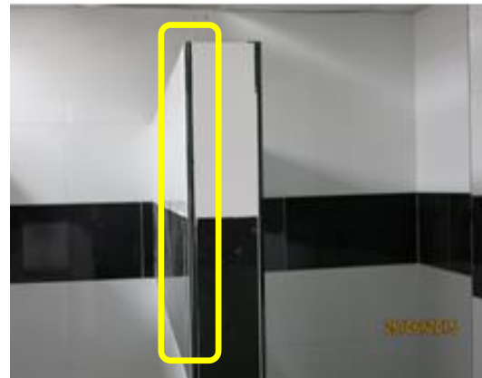
Gambar 2.9 Getah Sesudut Jubin Dipasang Di Dinding Tandas
