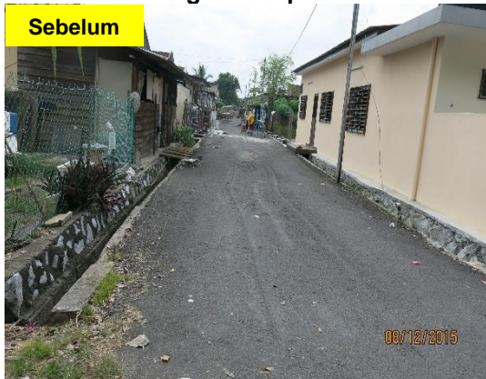
Gambar 1.22 Turapan Kasar Dan Tidak Dipadatkan Dengan Sempurna
