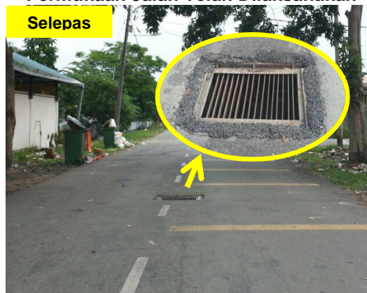
Gambar 1.19 Kerja Menurap Aras Manhole Selaras Dengan Permukaan Jalan Telah Dilaksanakan
