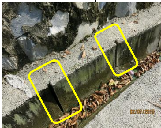
Gambar 2.12 Keadaan Longkang Yang Dipasang Tidak Rapat
