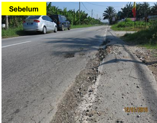
Gambar 1.26 Jalan Yang Diturap Pada Bulan April 2015 Rosak Semula
