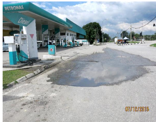
Gambar 1.31 Jalan Yang Diturap Pada Bulan Mac 2014 Rosak Semula
