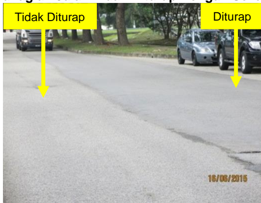
Gambar 2.14 Bahagian Jalan Tidak Diturap Dengan Sekata
