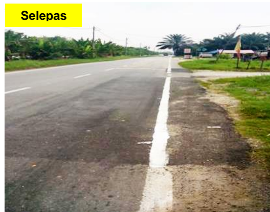
Gambar 1.27 Jalan Yang Diturap Pada Bulan April 2015 Rosak Semula Telah Dilaksanakan Pembaikan
