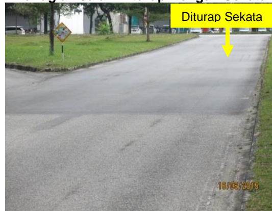
Gambar 2.15 Bahagian Jalan Diturap Dengan Sekata
