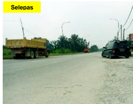
Gambar 1.6 Bahu Dan Jalan Rosak Telah Diambil Tindakan
