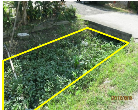
Gambar 3.1 Parit Tanah Yang Masih Belum Dinaik Taraf Kepada Longkang Konkrit
