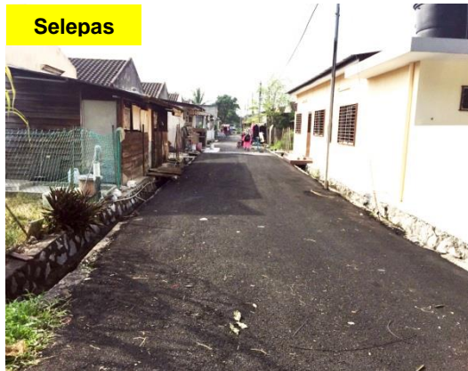
Gambar 1.23 Kerja Turapan Telah Dilaksanakan
