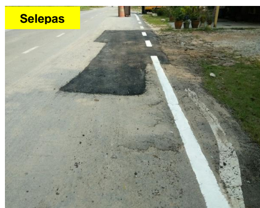
Gambar 1.25 Jalan Yang Diturap Pada Bulan November 2015 Rosak Semula Telah Dilaksanakan Pembaikan
