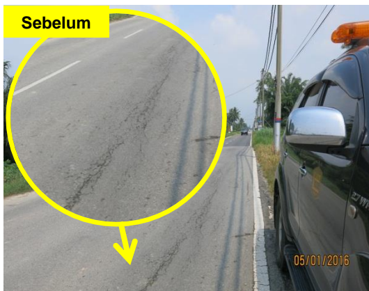
Gambar 1.3 Jalan Retak
