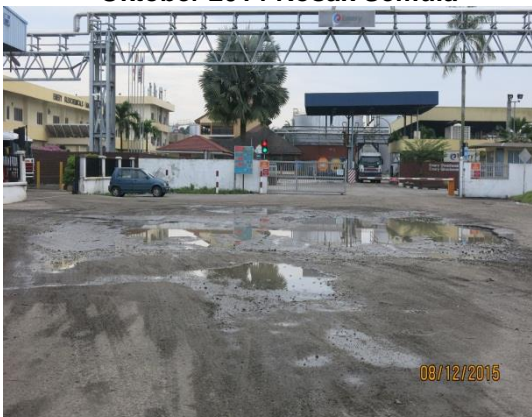
Gambar 1.28 Jalan Yang Diturap Pada Bulan Oktober 2014 Rosak Semula
