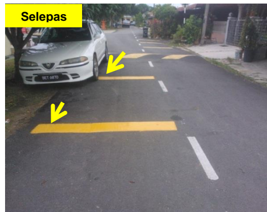
Gambar 1.15 Traverse Bar Telah Dicat
