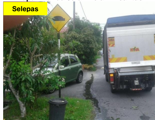
Gambar 1.8 Dahan Pokok Yang Menghalang Papan Tanda Jalan Telah Dicantas
