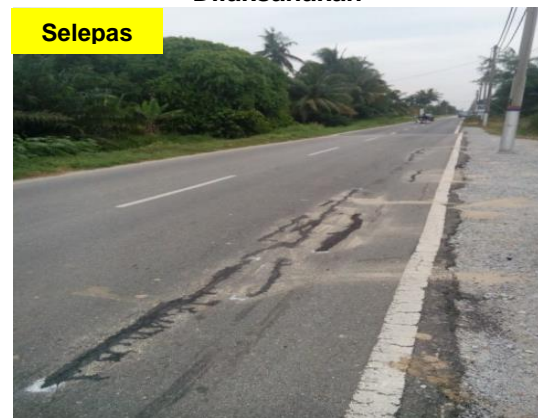
Gambar 1.4 Kerja Pembaikan Terhadap Retak Jalan Telah Dilaksanakan
