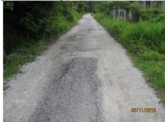
Gambar 1.25 Penyenggaraan Pavement (Menurap Semula Jalan) Tidak Dilakukan
