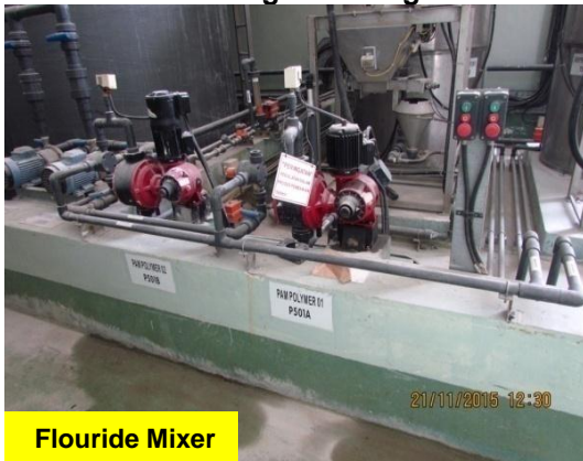
Gambar 3.9 Peralatan Yang Tidak Digunakan
