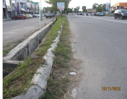
Gambar 1.17 Bahu Jalan Tidak Disenggarakan
