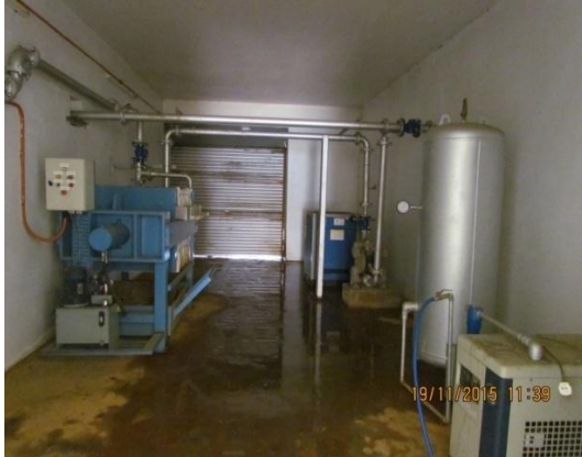
Gambar 3.7 Filter Press Tidak Digunakan
