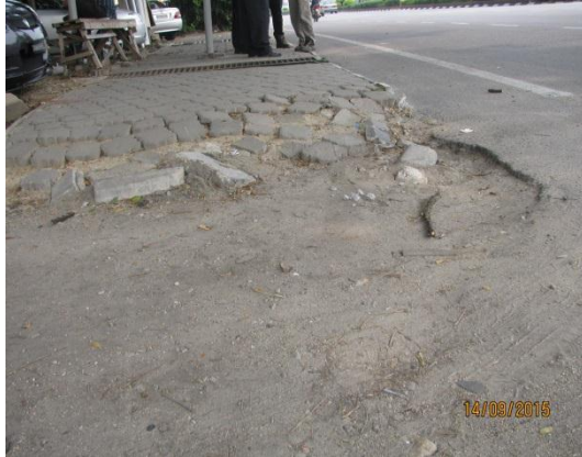
Gambar 1.17 Bahu Jalan Tidak Disenggarakan
