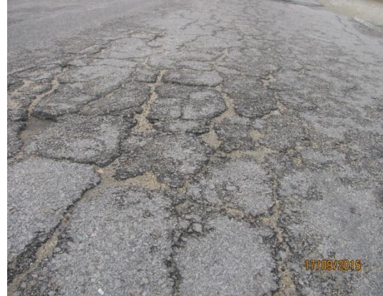
Gambar 1.21 Penyenggaraan Pavement (Menurap Semula Jalan) Tidak Dilakukan
