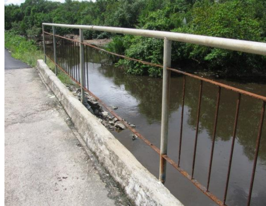
Gambar 1.11 Pagar Jambatan Tidak Disenggarakan
