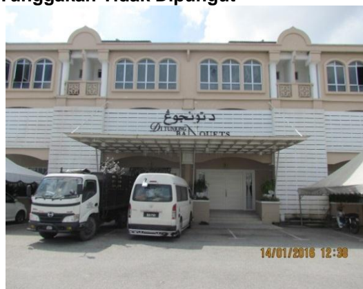
Sumber: Jabatan Audit Negara Lokasi: Jalan Kuala Krai Kota Bharu Tarikh: 14 Januari 2016
