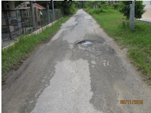
Gambar 1.25 Penyenggaraan Pavement (Menurap Semula Jalan) Tidak Dilakukan
