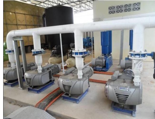
Gambar 3.28 Komponen Sistem UF Yang Tidak Dapat Digunakan
