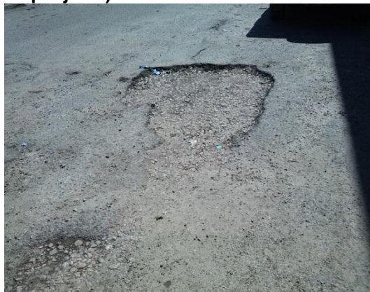
Gambar 1.1 Penyenggaraan pavement (menampal jalan) tidak dilakukan
