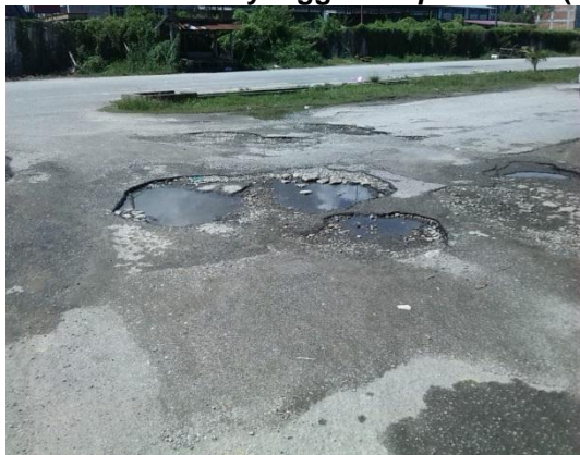
Gambar 1.1 Penyenggaraan pavement (menampal jalan) tidak dilakukan
