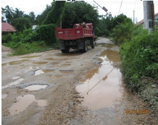
Gambar 1.23 Penyenggaraan Pavement (Menurap Semula Jalan) Tidak Dilakukan
