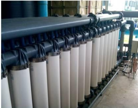
Gambar 3.27 Komponen Sistem UF Yang Tidak Dapat Digunakan
