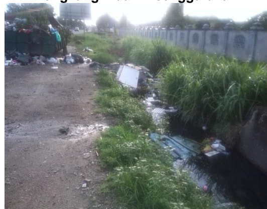
Longkang Tidak Disenggarakan
