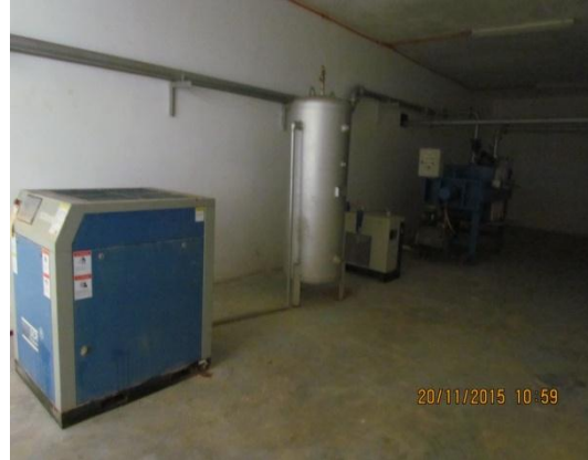
Gambar 3.8 Filter Press Tidak Digunakan
