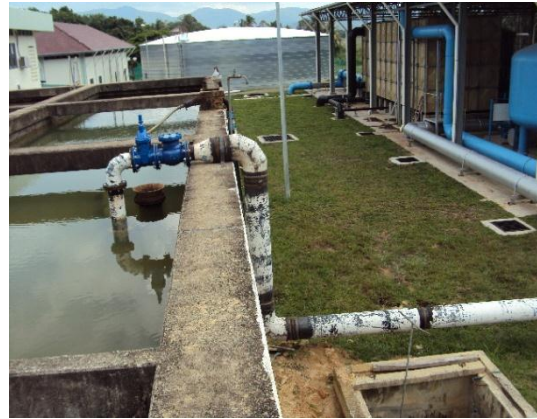
Gambar 3.26 Bypass proses Sistem UF
