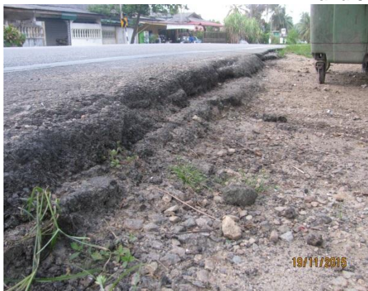
Gambar 1.3 Bahu Jalan Tinggi
