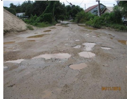
Gambar 1.23 Penyenggaraan Pavement (Menurap Semula Jalan) Tidak Dilakukan
