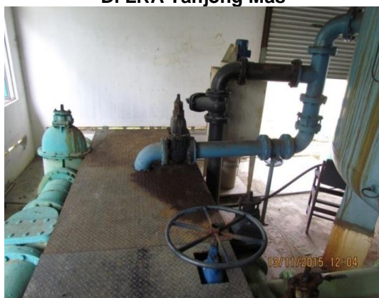
Gambar 3.3 Valve Tangki Penapis Bocor Di LRA Tanjong Mas
