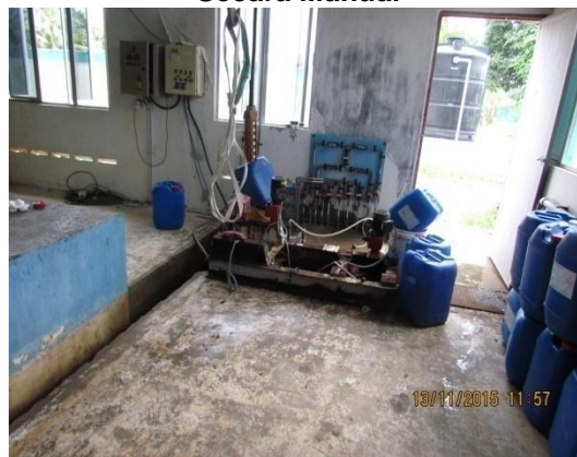
Gambar 3.17 Pendosaan Sodium Hypochlorite Secara Manual
