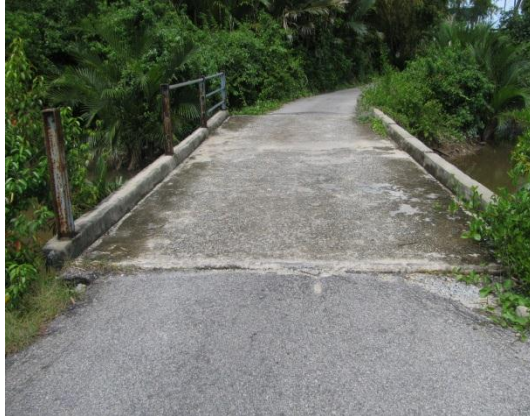
Gambar 1.11 Pagar Jambatan Tidak Disenggarakan
