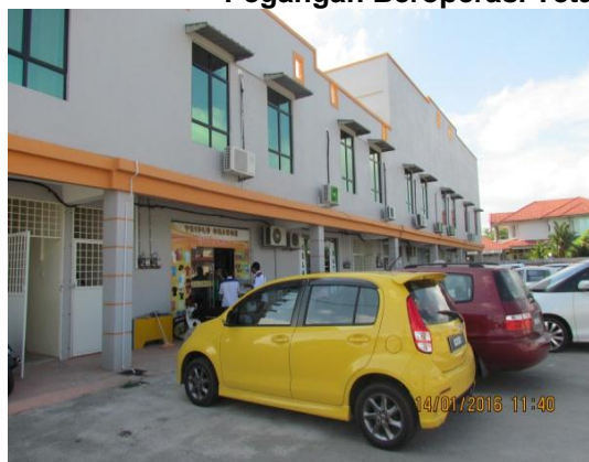
Sumber: Jabatan Audit Negara Lokasi: Jalan Padang Tembak Kota Bharu Tarikh: 14 Januari 2016
