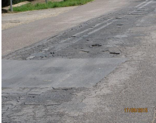
Gambar 1.21 Penyenggaraan Pavement (Menurap Semula Jalan) Tidak Dilakukan
