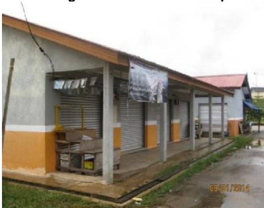
Gambar 3.11 Gerai Yang Disewakan Tidak Beroperasi
