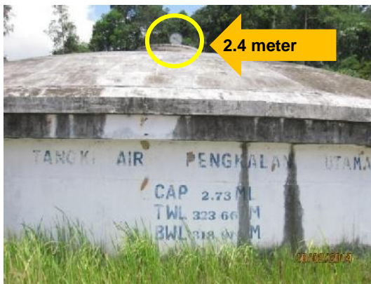
Gambar 4.7 Tangki Imbangan Kekeringan Dan Meter Penunjuk Bacaan Air Rosak
