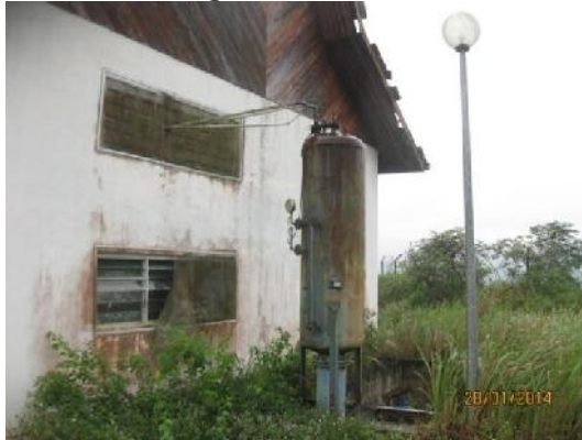
Gambar 4.5 Kawasan Bangunan Jana Kuasa Terbiar
