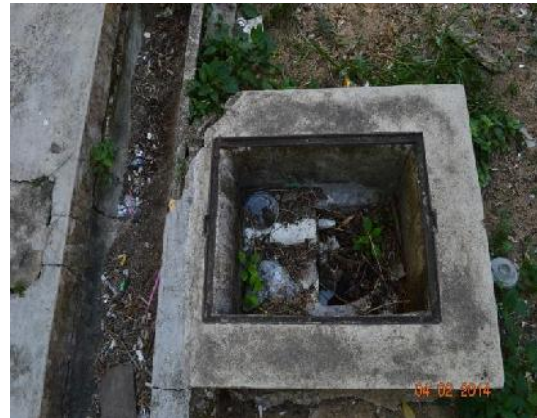
Gambar 2.13 Penutup Manhole (Lurang) Pecah
