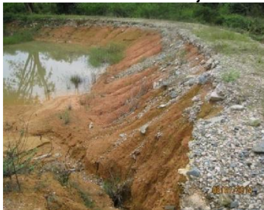
Gambar 3.8 Hakisan Pada Jalan Jejeri
