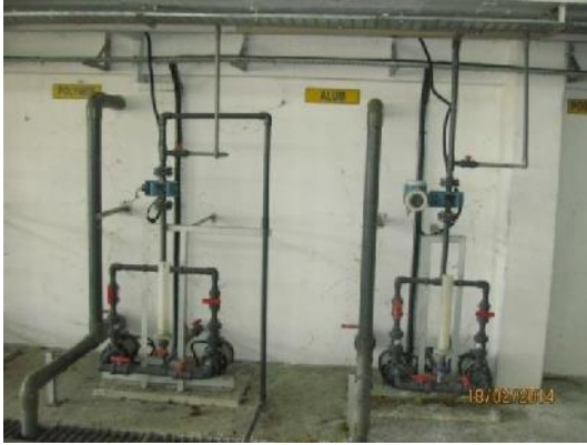
Gambar 4.3 Sebahagian Dosing Pump Yang Terbiar
