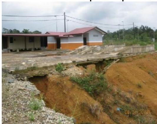
Gambar 3.7 Hakisan Tanah di Tapak Pelupusan
