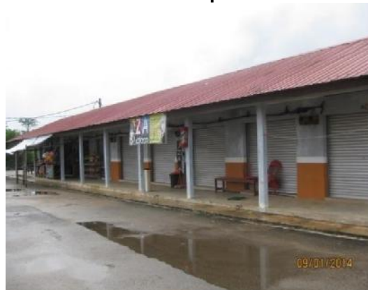
Gambar 3.10 Gerai Yang Disewakan Tidak Beroperasi
