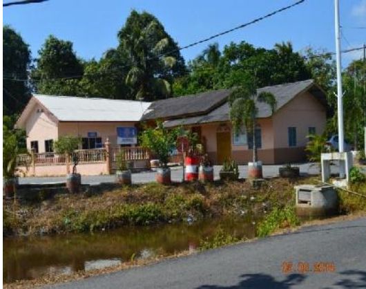
Sumber: Jabatan Audit Negara Lokasi: Balai Raya Kg. Pak Pa, Kuala Terengganu Tarikh: 5 Februari 2014
