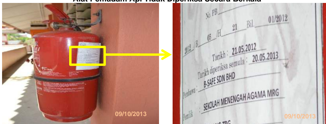
Gambar 2.18 Alat Pemadam Api Tidak Diperiksa Secara Berkala
