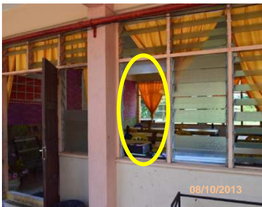
Gambar 2.12 Tingkap Tidak Mempunyai Cermin
