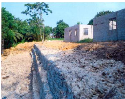
Gambar 1.14 Pembinaan Gabion Menggunakan Peruntukan Jalan
