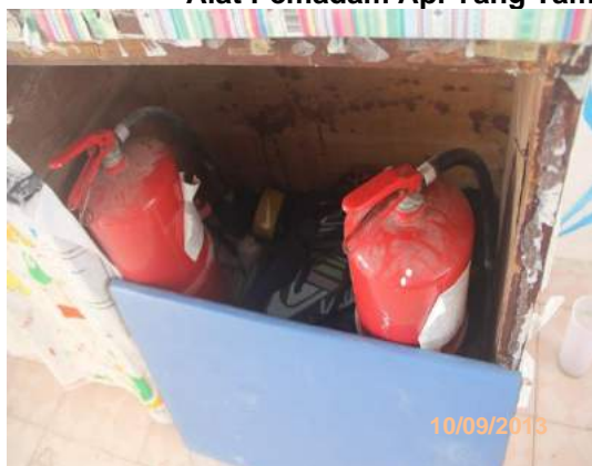
Gambar 2.20 Alat Pemadam Api Yang Tamat Tempoh Dan Tidak Digunakan
