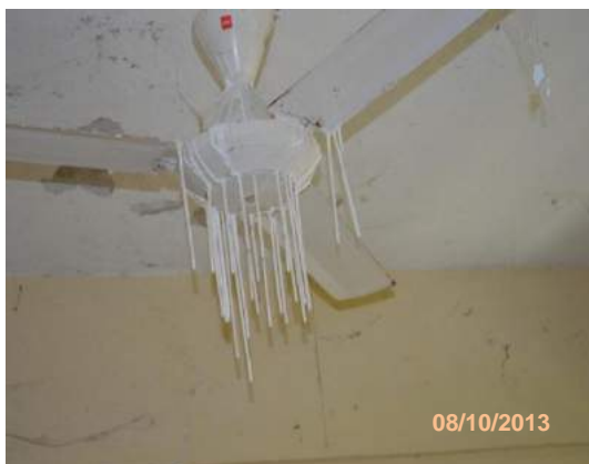
Gambar 2.13 Resapan Air Di Bahagian Bawah Lantai Konkrit Tingkat Atas Bilik Warden
