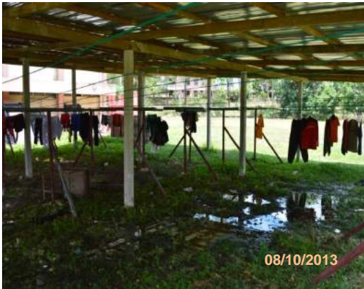
Gambar 2.14 Lantai Ampaian Tidak Berturap
