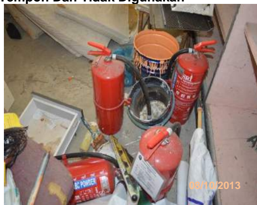
Gambar 2.20 Alat Pemadam Api Yang Tamat Tempoh Dan Tidak Digunakan
