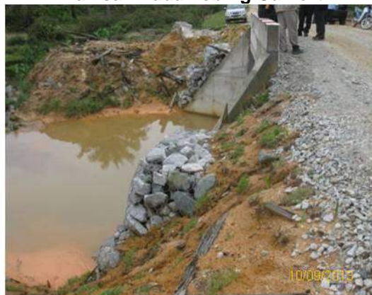
Gambar 1.6 Hakisan Pada Tebing Culvert
