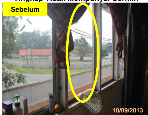
Gambar 2.10 Tingkap Tidak Mempunyai Cermin
