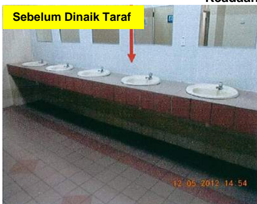
Gambar 2.15 Keadaan Tandas Dewan
