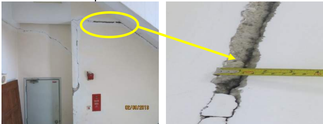
Gambar 2.11 Keretakan Pada Dinding Setebal 4 Sentimeter Masih Berlaku Walaupun Tindakan Pembaikan Telah Dilakukan
