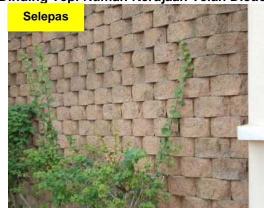
Gambar 1.18 Dinding Tepi Rumah Kerajaan Telah Dicuci
