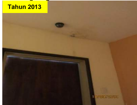
Gambar 2.8 Kesan Resapan Air Pada Siling Tingkat 6
