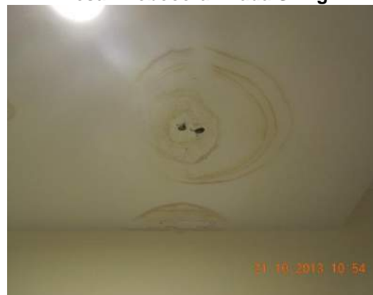
Gambar 1.6 Kesan Kebocoran Pada Siling
