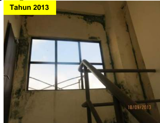
Gambar 2.6 Keadaan Dinding Yang Berlumut
