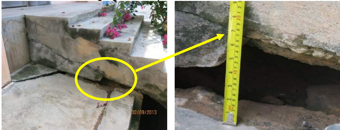
Gambar 2.10 Keretakan Dan Regangan Pada Apron Slab Dewan Setebal 17 Sentimeter
