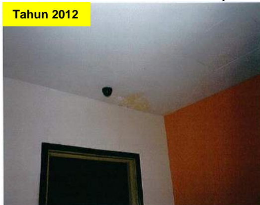
Gambar 2.8 Kesan Resapan Air Pada Siling Tingkat 6
