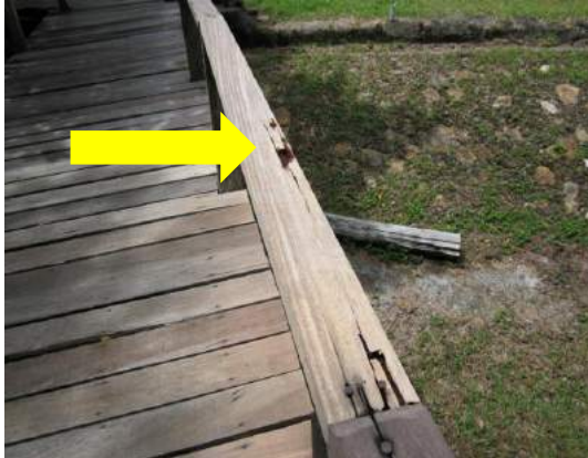
Gambar 3.5 Rel Tangan Laluan Pejalan Kaki Telah Dibaiki Tetapi Rosak Semula
