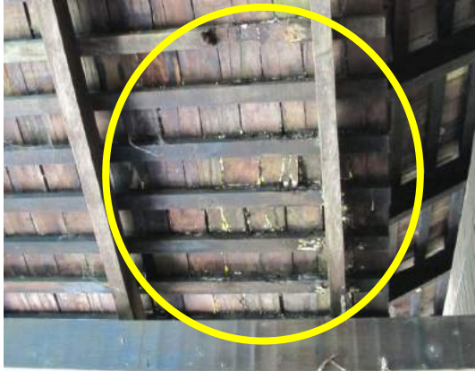
Gambar 3.3 Struktur Bumbung Yang Diperbuat Daripada Kayu Telah Reput Dan Berkulat
