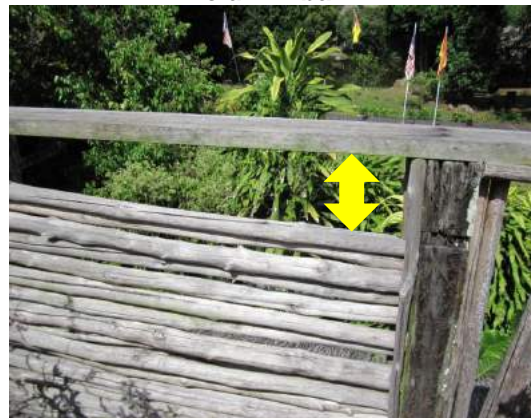
Gambar 3.7 Pagar Serambi Restoran Rosak Dan Belum Dibaiki
