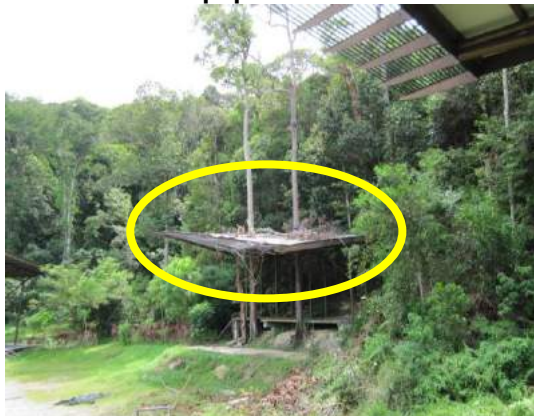
Gambar 3.9 Keadaan Bumbung Pentas Terbuka Rosak Dihempap Dahan Pokok Patah
