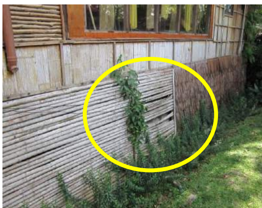
Gambar 3.1 Dinding Bangunan Yang Diperbuat Daripada Buluh Telah Rosak
