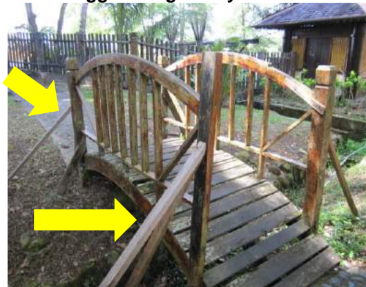
Gambar 3.10 Jambatan Kurang Stabil Dan Perlu Disanggar Dengan Kayu Tambahan
