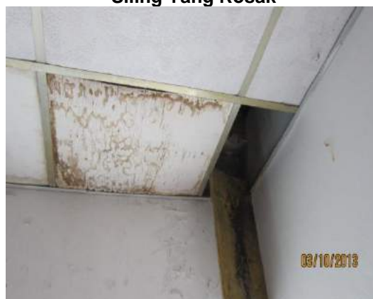
Gambar 4.6 Siling Yang Rosak
