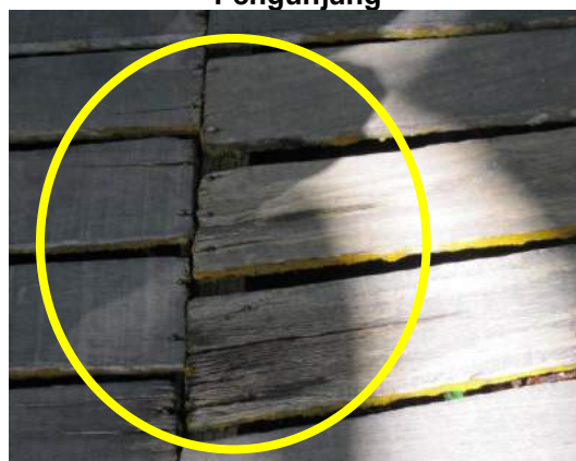
Gambar 3.2 Papan Kayu Laluan Pejalan Kaki Yang Reput Dan Kurang Selamat Kepada Pengunjung
