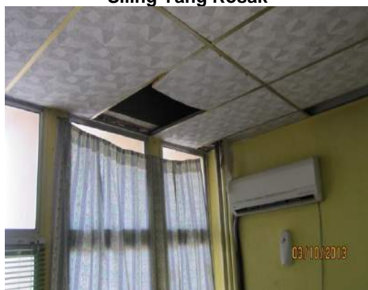
Gambar 4.5 Siling Yang Rosak
