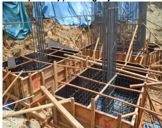
Gambar 4.6 Kerja-Kerja Pembinaan Tetopi Cerucuk ( Pile Cap ) Sedang Dijalankan
