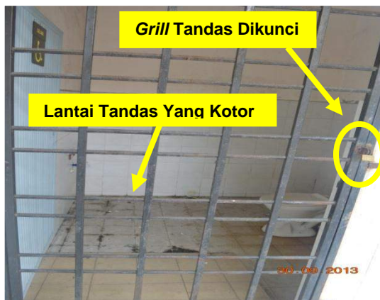
Gambar 3.8 Tandas Di Kompleks Makanan Tidak Dibersihkan Dan Berkunci
