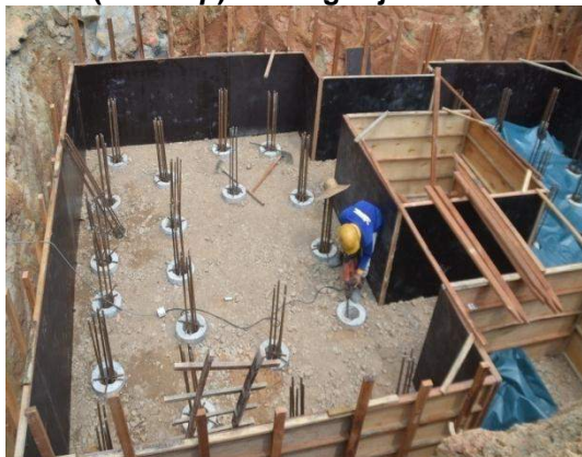
Gambar 4.5 Kerja-Kerja Pembinaan Tetopi Cerucuk ( Pile Cap ) Sedang Dijalankan
