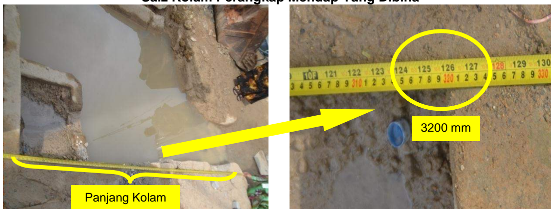
Gambar 4.9 Saiz Kolam Perangkap Mendap Yang Dibina
