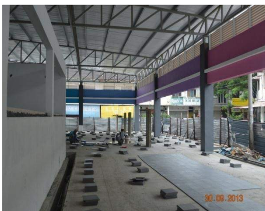
Gambar 3.3 Pekerja Kontraktor Sedang Memasang Jubin Lantai Pasar
