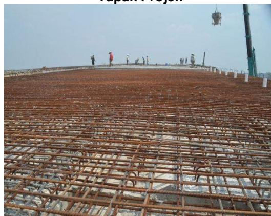
Gambar 4.2 Kerja Pembinaan Sedang Dijalankan Di Tapak Projek
