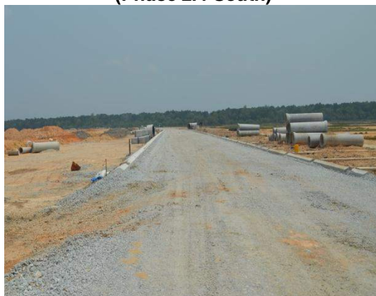
Gambar 4.3 Kerja Pembinaan Jalan Masih Belum Disiapkan di Lingkaran Cassia Selatan (Phase 2A-South)
