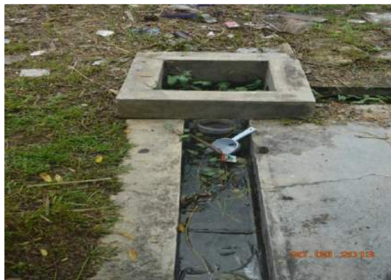
Gambar 3.7 Longkang Di Kompleks Makanan Tersumbat Dan Tidak Dibersihkan
