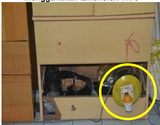
Gambar 3.5 Penyambungan Elektrik Yang Menggunakan Extension Wire
