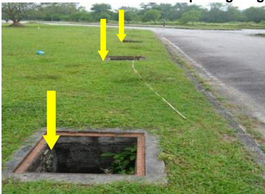
Gambar 2.22 Penutup Longkang Yang Hilang dan Rosak
