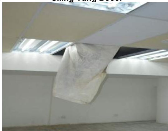
Gambar 2.11 Siling Yang Bocor
