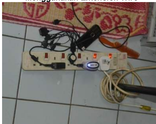
Gambar 3.6 Penyambungan Elektrik Yang Menggunakan Extension Wire
