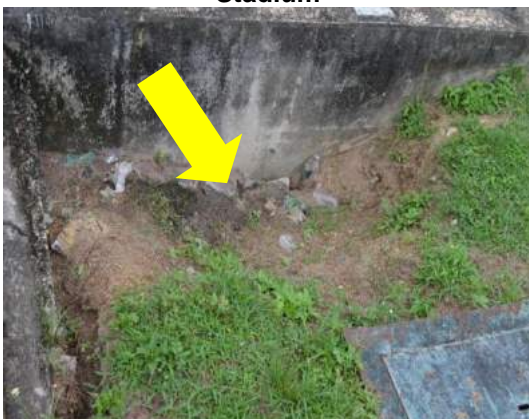
Gambar 2.16 Tanah Mendap Di Tepi Parit Dalam Stadium
