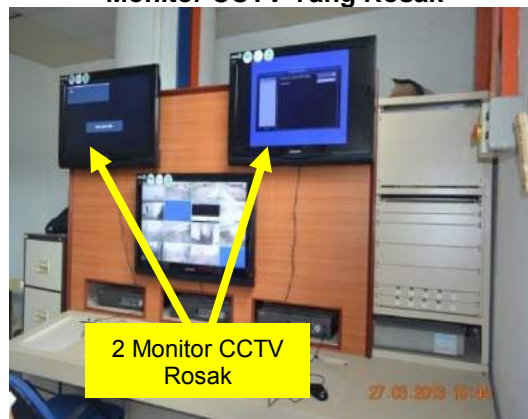
Gambar 2.19 Monitor CCTV Yang Rosak
