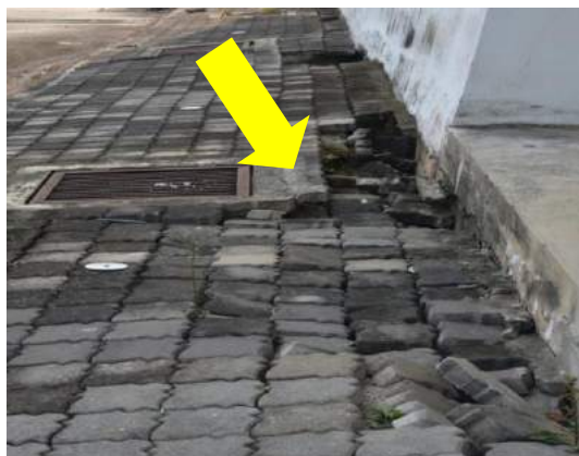
Gambar 2.15 Interlocking Yang Rosak
