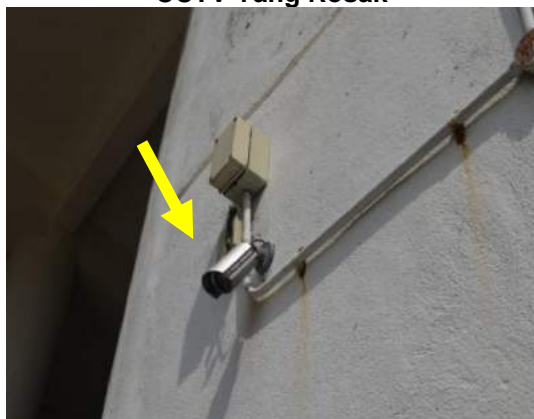
Gambar 2.18 CCTV Yang Rosak
