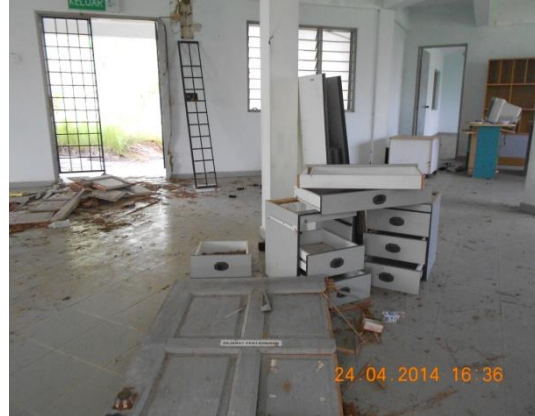
Gambar 2.7 Keadaan Bangunan Yang Terbiar Tidak Disenggara
