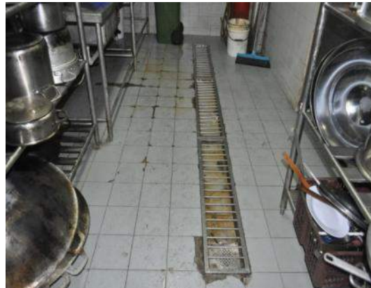
Gambar 1.16 Keadaan Lantai Dapur Yang Kotor, Pecah Dan Licin
