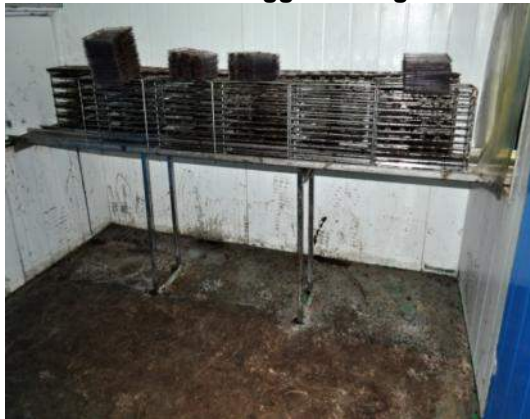
Gambar 1.13 Lantai Bilik Sejuk Beku Kotor Dan Tidak Diselenggara Dengan Baik
