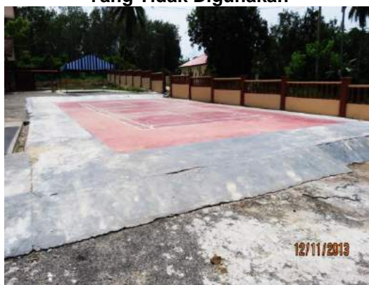
Gambar 3.1 Gelanggang Sepak Takraw Yang Tidak Digunakan
