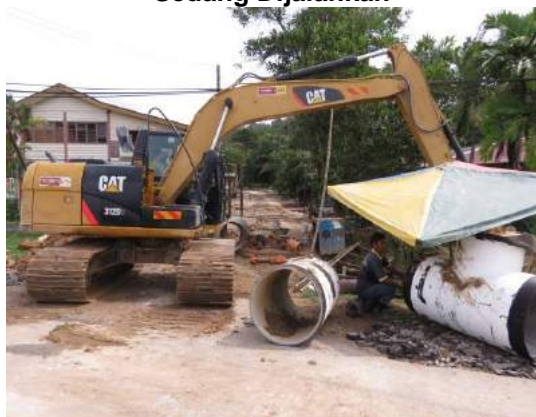
Gambar 3.9 Kerja Pemasangan Paip Sedang Dijalankan
