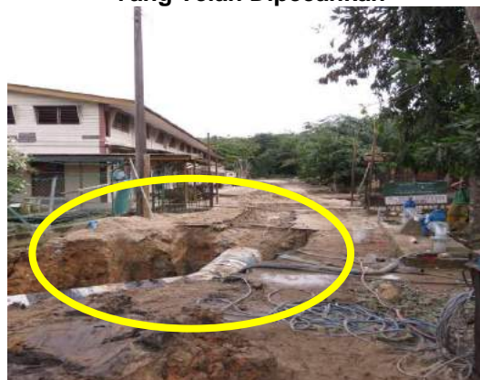
Gambar 3.10 Paip Utama Di Bawah Jalan Yang Telah Dipecahkan
