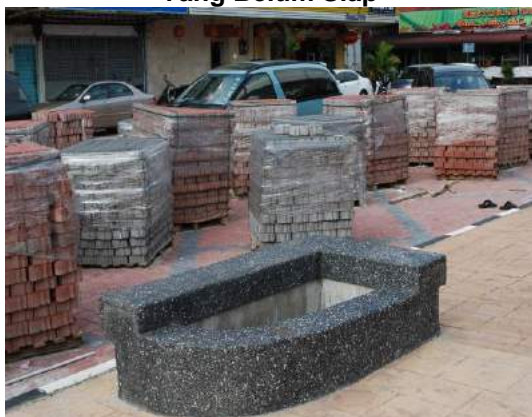
Gambar 2.3 Interlocking Pavers Yang Belum Siap
