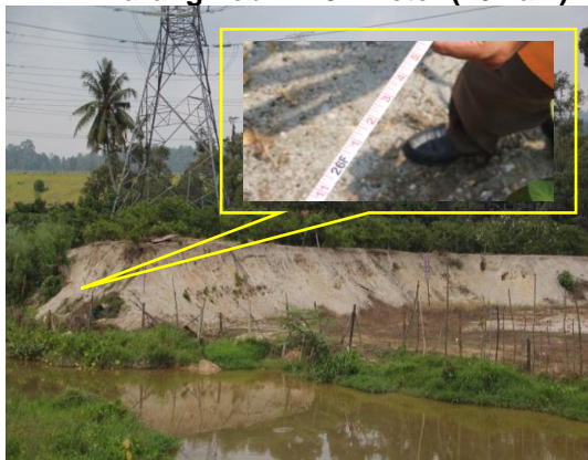
Gambar 1.8 Jarak Kerosakan Tebing Dengan Menara TNB Kurang Lebih 7.92 Meter (26 kaki)
