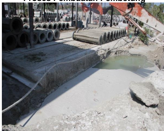
Gambar 1.7 Kolam Enap Cemar Yang Dibina Tidak Dapat Menampung Aliran Keluar Air Dari Proses Pembuatan Pembetung
