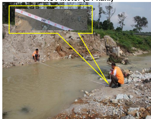
Gambar 1.9 Kelebaran Sungai Mengecil Kepada 7.31 Meter (24 kaki)
