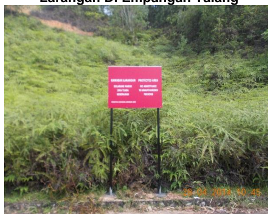
Gambar 1.2 Pemasangan Papan Tanda Kawasan Larangan Di Empangan Talang
