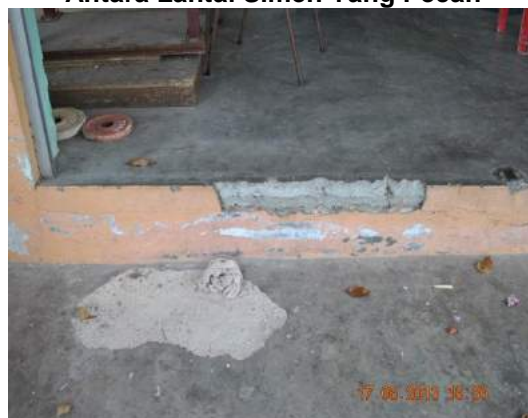
Gambar 2.12 Antara Lantai Simen Yang Pecah
