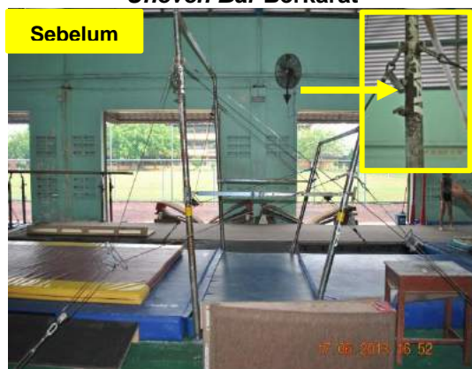
Gambar 2.33 Uneven Bar Berkarat
