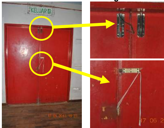
Gambar 2.6 Kunci Pintu Dewan Yang Rosak
