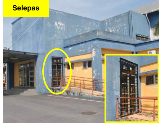
Gambar 2.2 Pintu Dewan Yang Telah Dipasang Jeriji Besi
