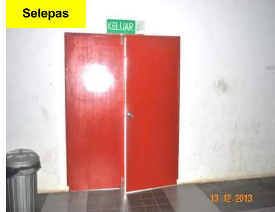
Gambar 2.4 Pintu Masuk Dewan Yang Telah Ditukar Baru
