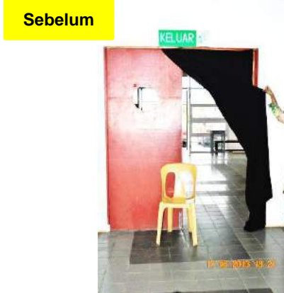
Gambar 2.3 Pintu Masuk Dewan Yang Rosak Ditutup Dengan Kain
