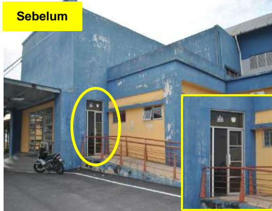
Gambar 2.1 Dewan MSN Yang Tidak Disenggara Dan Pintu Dewan Yang Tiada Jeriji Besi
