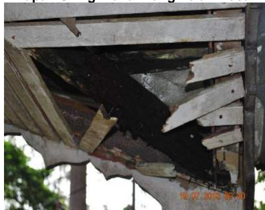
Gambar 1.14 Papan Siling Wakaf Yang Telah Rosak
