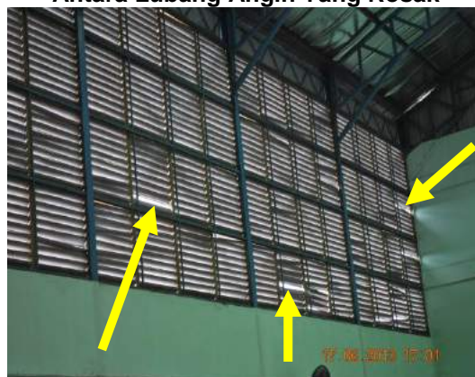
Gambar 2.8 Antara Lubang Angin Yang Rosak
