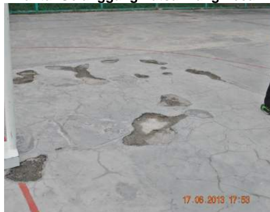
Gambar 2.20 Lantai Gelanggang Futsal Yang Pecah
