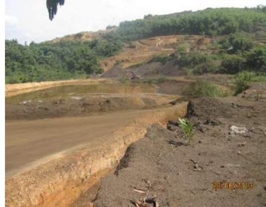
Gambar 2.6 Tanah Ditarah Secara Tidak Terkawal
