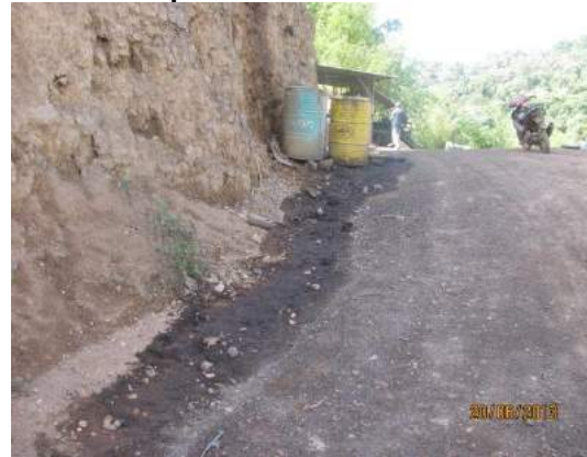
Gambar 2.13 Minyak Diesel Dibiarkan Tumpah
