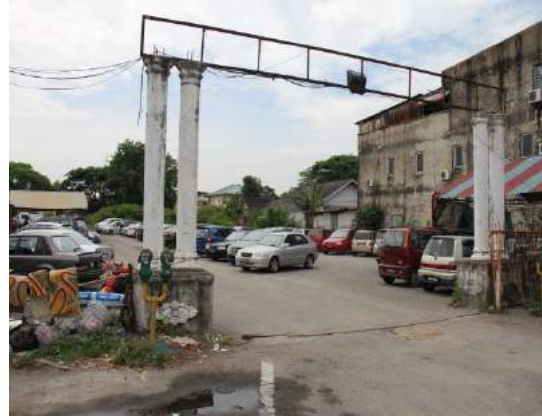
Sumber: Jabatan Audit Negara Lokasi: Jalan Kebun Sultan Tarikh: 20 Mac 2013
