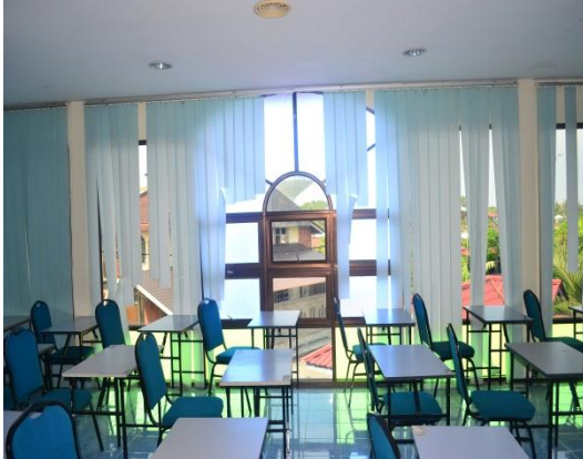
Gambar 3.5 Keadaan Dewan Sultanah Bahiyah Dengan Langsir Yang Koyak
