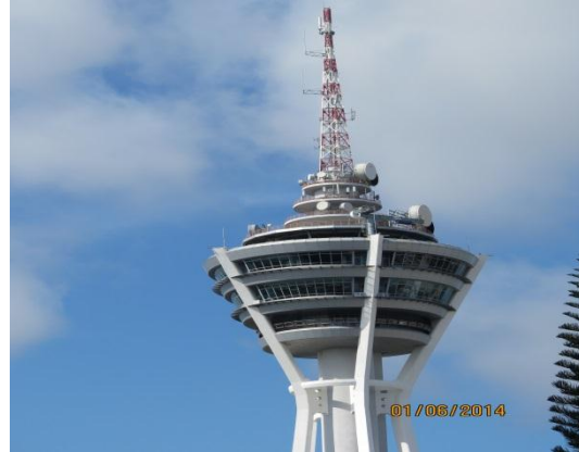
Gambar 4.4 Struktur Telekomunikasi Di Atas Menara Telekom
