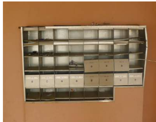
Gambar 1.12 Peti Surat Yang Dirosakkan Akibat Vandalisme
