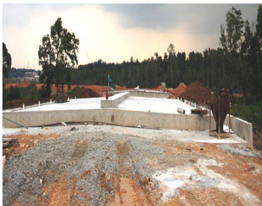
Gambar 1.15 Kerja Membina Jambatan Sedang Dijalankan
