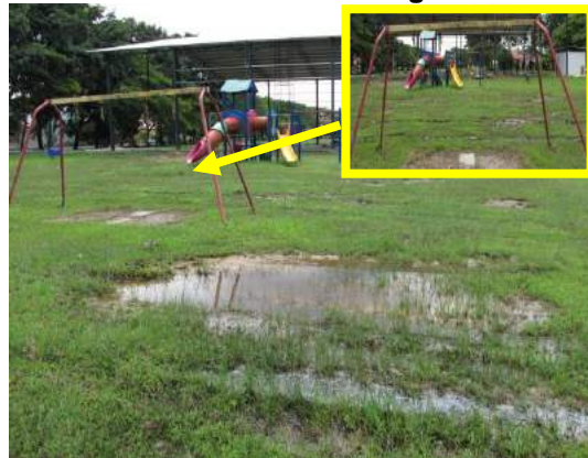
Gambar 2.9 Tali Dan Tempat Duduk Buaian Tercabut Dan Air Bertakung
