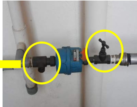
Gambar 1.6 Paip Penyambung Meter Air Sepatutnya
