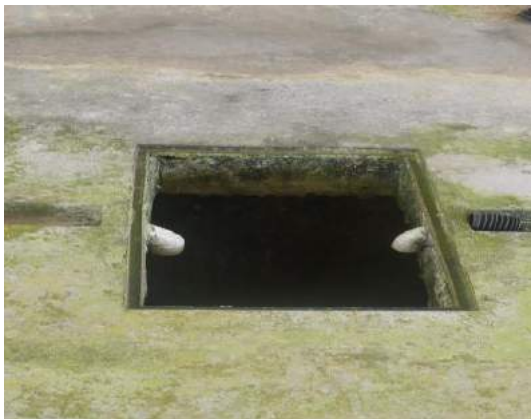
Gambar 1.11 Penutup Lubang Telah Dicuri
