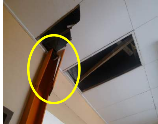
Gambar 1.10 Wayar Elektrik Telah Dicuri
