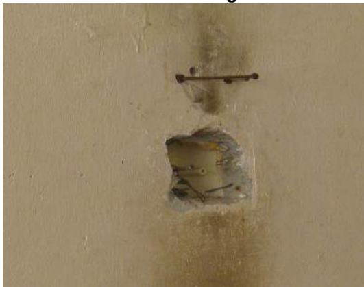
Gambar 1.20 Pendawaian Elektrik Unit Rumah Kosong Telah Hilang
