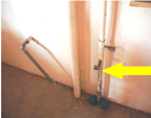
Gambar 1.5 Kehilangan Paip Penyambung Meter Air Akibat Vandalisme
