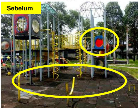
Gambar 2.6 Permukaan Lantai Kotor Dan Gelongsor Rosak
