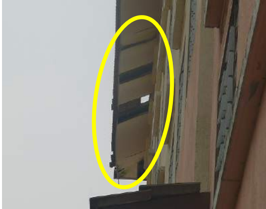
Gambar 1.9 Bumbung Rumah Pangsa Bocor
