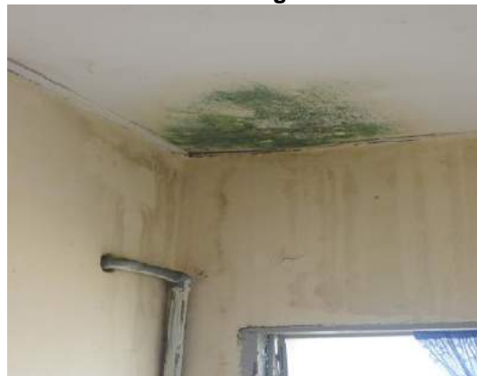
Gambar 1.21 Resapan Air Pada Siling Unit Rumah Kosong
