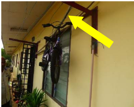
Gambar 1.31 Buluh Penyidai Baju Membahayakan Keselamatan
