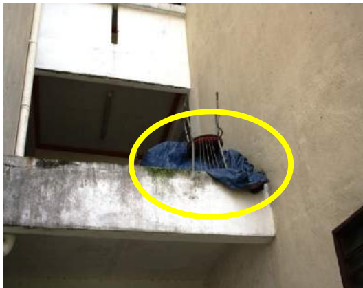
Gambar 1.28 Penyimpanan Barangan Di Tepi Tangga Membahayakan Keselamatan
